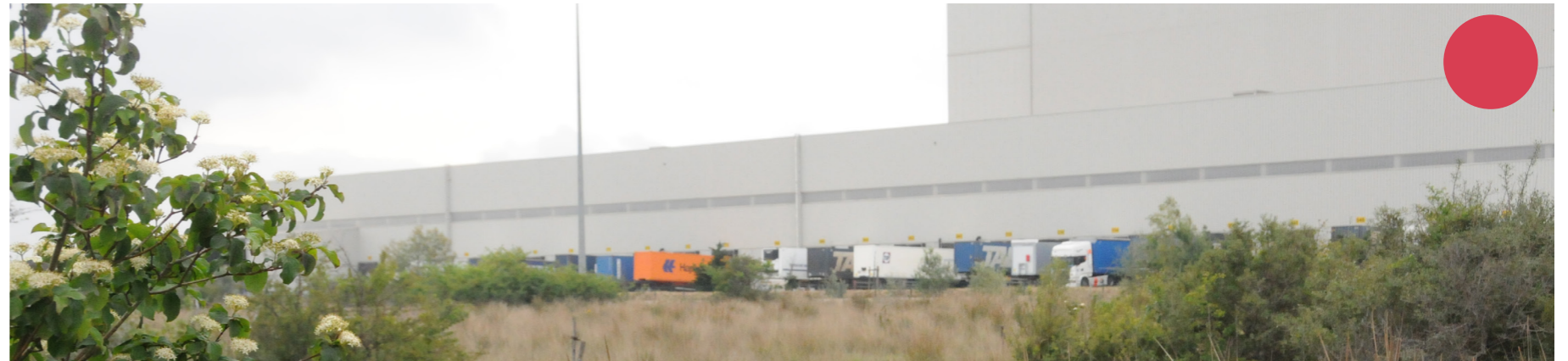
Point de vue sur l'entrepôt IKEA
