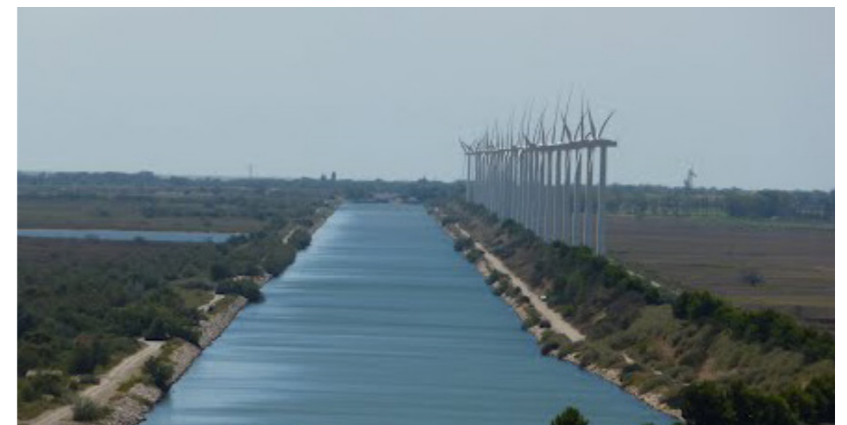
Vue du canal et des éoliennes
