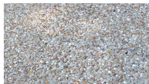
Revêtement : béton désactivé
