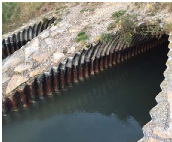
OH4 vu depuis le délaissé sud-ouest
