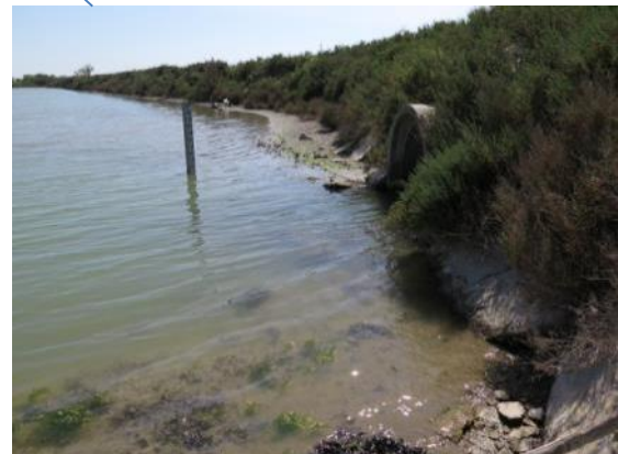
OH1 vu depuis le délaissé nord-ouest
