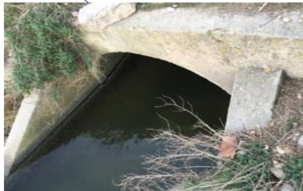
OH3 vu depuis le délaissé sud-ouest
