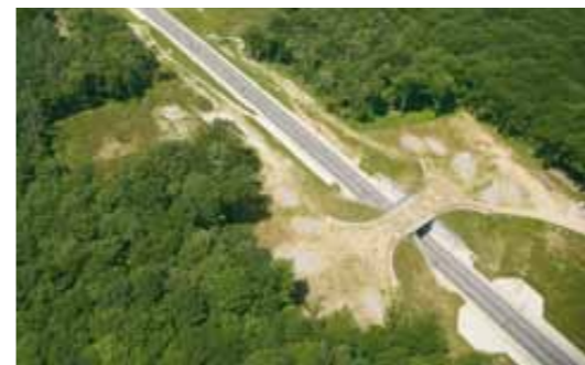
Passage à grande faune (cerfs, chevreuils...) et mares sur la ligne à grande vitesse Rhin-Rhône (crédit photo : RFF)
