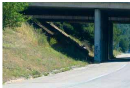
Châteauneuf-les-Martigues : viaduc de la RD 9, un franchissement potentiel de l'ASS au niveau des Aiguilles (crédit photo : Asconit/Biotope)
