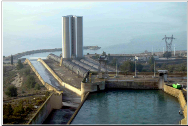
Figure 6 : Photographie de l'usine hydroélectrique de Saint-Chamas (Source : Serge Gueroult, Archive La Provence).
