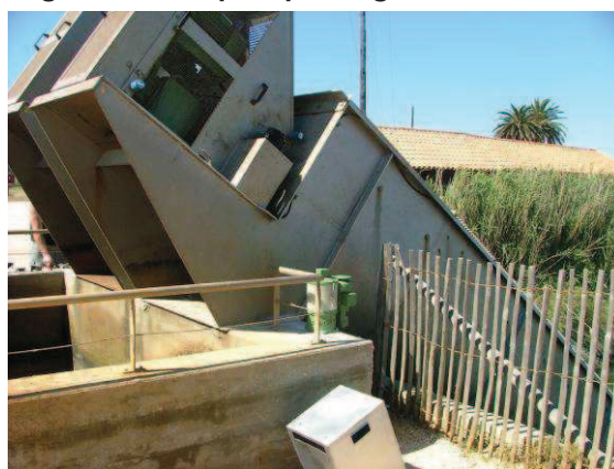
Station de vidange des Pesquiers : ↑ Changement des poulies et courroies sur l'unité 1 ↓ Changement des pompes à graisses sur les deux unités.
