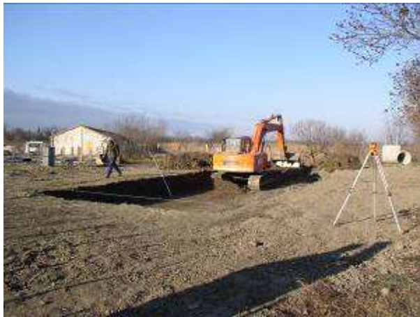
Réalisation du fond de forme et présentation du feutre de fond de lit
