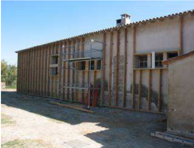
Mise en place de l'ensemble de l'ossature et des panneaux pare-pluie qui recevront le mélange roseaux-chaux
