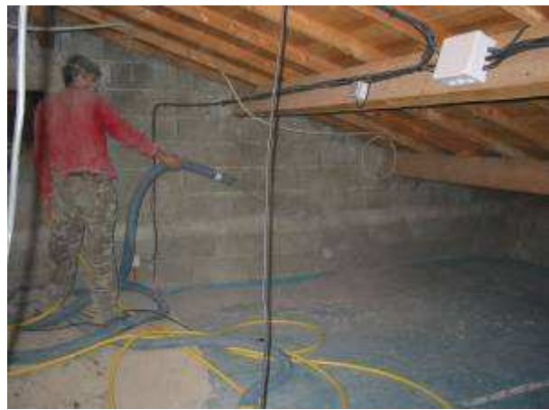
Après la pose d'un pare-poussières, insufflation de la cellulose en vrac sur 35cm
