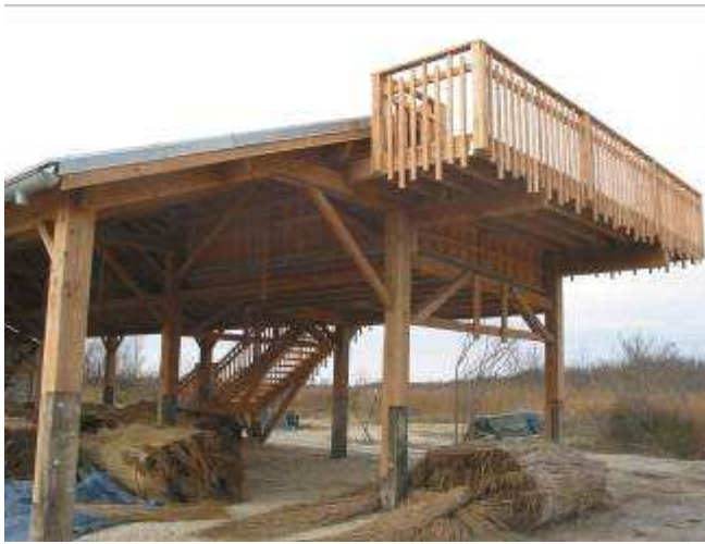
Installation des rambardes
