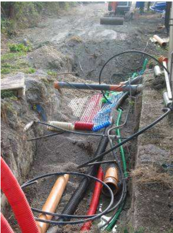
Complexité des réseaux, avec des réseaux neufs : gaines électriques (rouges), eaux usées, récupération des eaux pluviales et mise en équilibre des cuves d'eau pluviale (tuyaux oranges), alimentation des sanitaires en eau pluviale (petit tuyau noir), réseau de chaleur (gros tuyau noir), réseau Télécom (gaine verte), et des réseaux existants : eau potable (petit tuyau noir), évacuation temporaire des eaux usées (tuyau gris), ...
