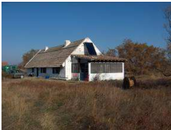
Cabane de Gardian (2m 2 de capteurs solaires thermiques)
