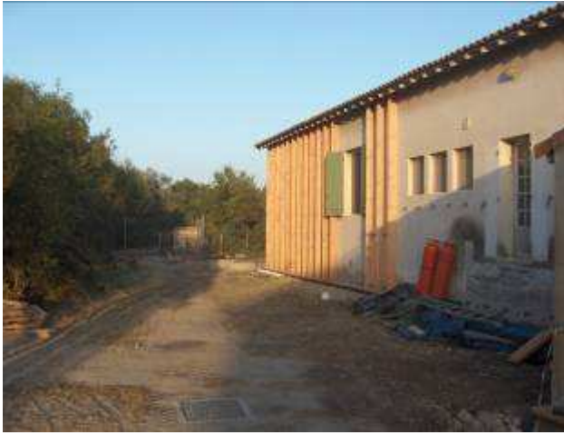
Mise en place de l'ossature en douglas, ainsi que des cadres qui recevront les fenêtres extérieures
