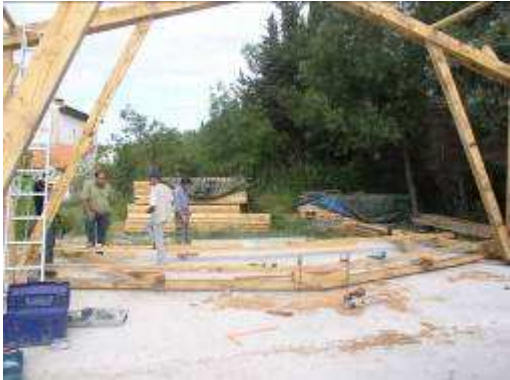
Assemblage au sol et mise en place progressive avec un tractopelle (structure en chêne lourd)
