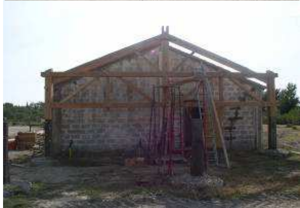
Assemblage et montage de la première ferme
