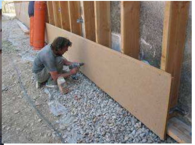
Mise en place de l'ensemble de l'ossature et des panneaux pare-pluie qui recevront le mélange roseaux-chaux
