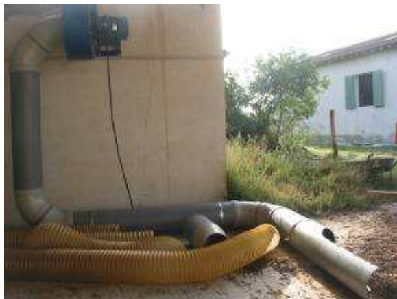
Détail du système d'alimentation du silo de la chaufferie (aspirateur à copeaux)
