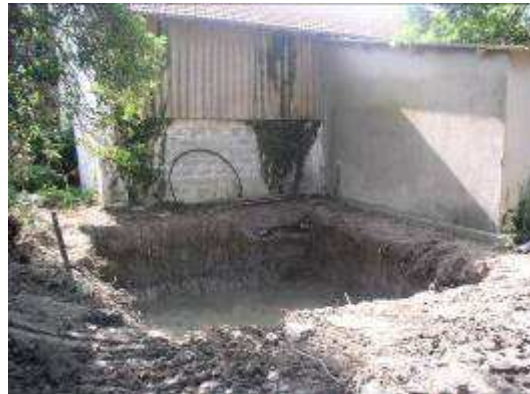
Positionnement de la deuxième cuve et creusement
