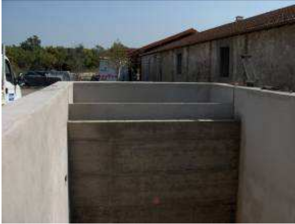
Décanteur fini (la partie haute permet d'éviter l'intrusion de feuille dans la cuve centrale) et aspect finalisé
