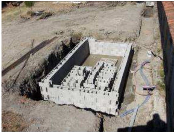
Montage du mur et réalisation de l'arrase
