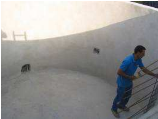
Réalisation des réservations (connexion des cuves entre elles, trop-plein) et du décanteur
