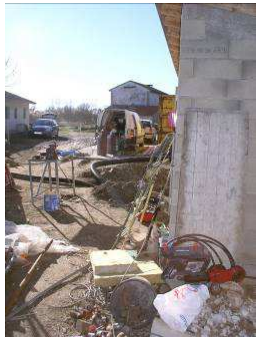
Aménagement du local chaufferie et pose du réseau de chaleur (tuyaux noirs)
