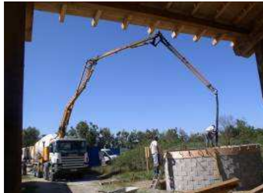
Coffrage et coulage des arases avec la pompe à béton
