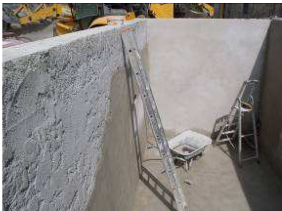
Réalisation de l'enduit d'étanchéification et du décanteur
