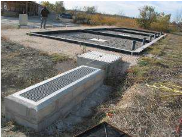
Pose des regards d'arrivée d'eau usée, du dégrilleur et du poste de relèvement
