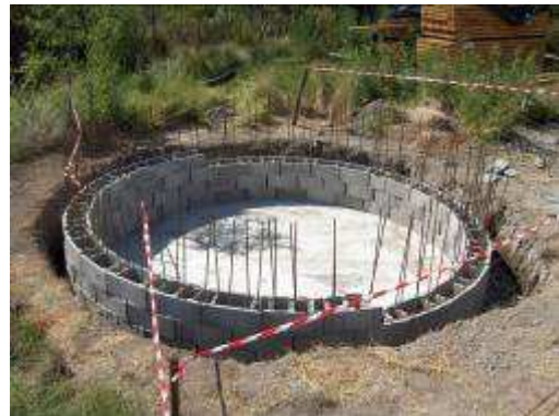
Montage des murs de la troisième cuve
