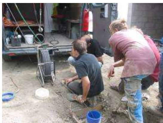
Après contrôle à l'étanchéité (en haut à gauche) et passage de caméra (ci-dessus et en bas à droite), le puits n'est pas étanche (ce problème sera réglé par l'ajout de bridages supplémentaires) et présente des « flashes » (discontinuités de pentes) problématiques
