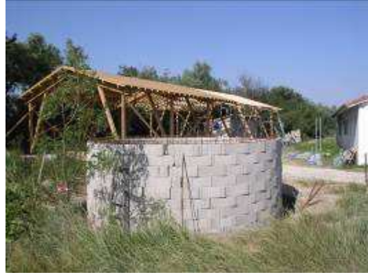
Fin du montage des murs
