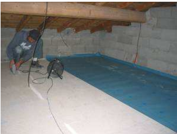
Après la pose d'un pare-poussières, insufflation de la cellulose en vrac sur 35cm
