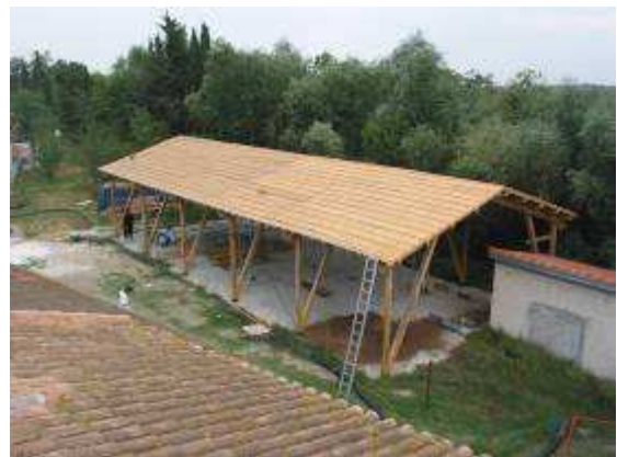
Mise en place des pannes et du voligeage
