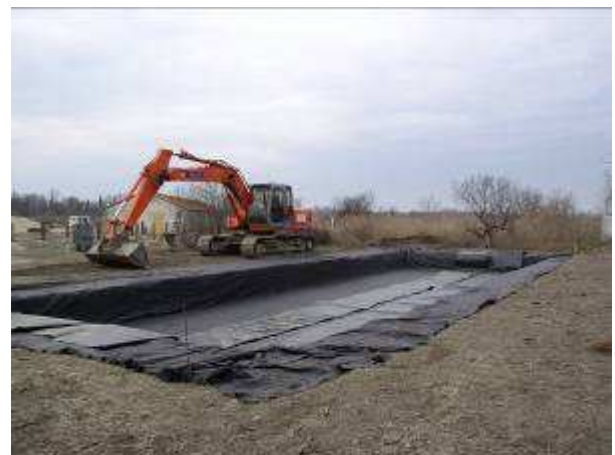
Pose du feutre de fond de lit et de la membrane d'étanchéité
