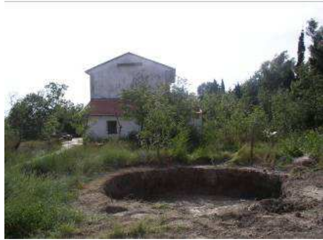
Creusement de la troisième cuve
