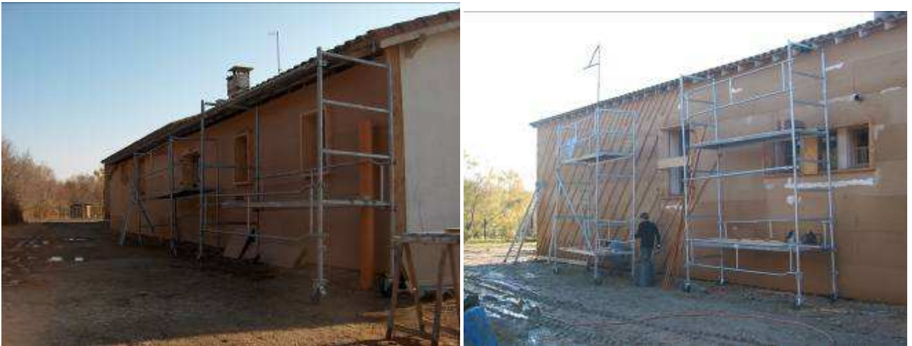
« Litonnage » en biais pour réaliser une lame d'air ; le bardage extérieur, en Douglas, reste à poser.
