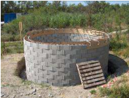
Coffrage et coulage des arases avec la pompe à béton
