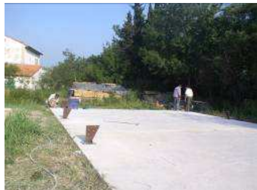
Déchargement de la chaudière bois (Hertz de 90kW) et pose des sabots de maintien de la structure bois
