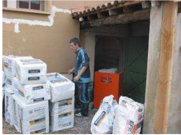
Isolation des combles par des panneaux de cellulose (gauche) ou de la cellulose en vrac (droite)
