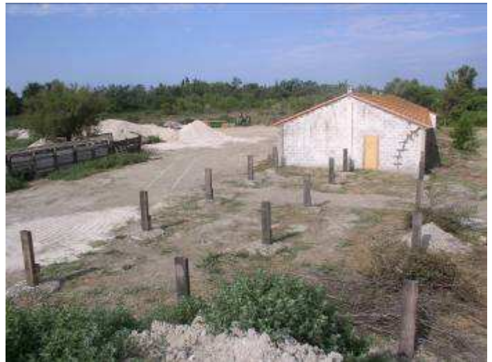
Poteaux de chêne de 25cm par 25 et servant de fondation au hangar (à gauche). Vue des fondations achevées (à droite). La découpe dans les poteaux en chêne accueillera quelques mois plus tard, une fois les fondations stabilisées, l'ossature en douglas. En cas de pourrissement prématuré d'un poteau, celui-ci pourra être changé par simple étayage, sans avoir à démonter l'ensemble du hangar.
