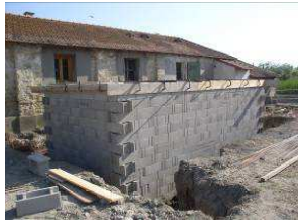
Montage du mur et réalisation de l'arrase
