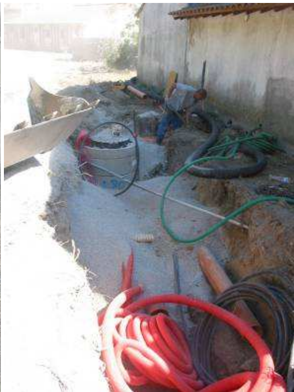
Complexité des réseaux, avec des réseaux neufs : gaines électriques (rouges), eaux usées, récupération des eaux pluviales et mise en équilibre des cuves d'eau pluviale (tuyaux oranges), alimentation des sanitaires en eau pluviale (petit tuyau noir), réseau de chaleur (gros tuyau noir), réseau Télécom (gaine verte), et des réseaux existants : eau potable (petit tuyau noir), évacuation temporaire des eaux usées (tuyau gris), ...
