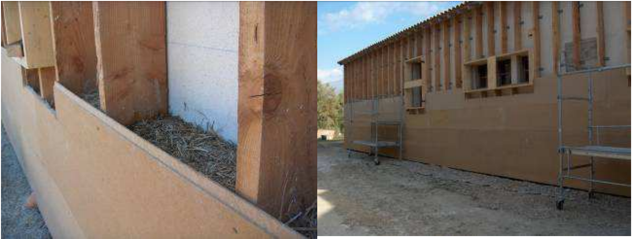
Remplissage progressif des caissons avec les déchets de roseaux
