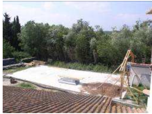
Assemblage au sol de la première ferme du hangar et mise en place
