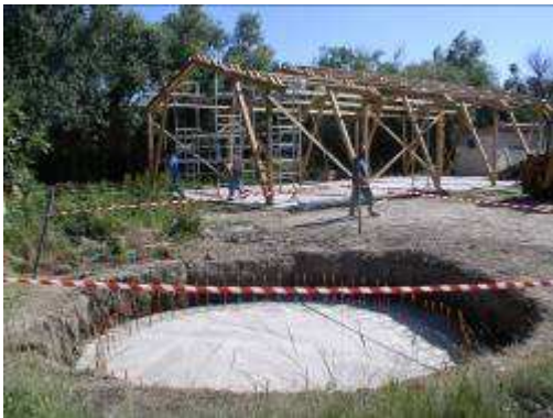
Fondations et montage des murs de la troisième cuve
