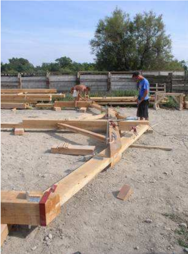
Assemblage et montage de la première ferme
