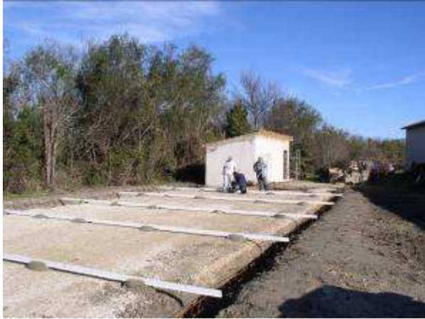
Réalisation de la dalle de la plateforme de stockage du bois (fondations, joints de dilatation, treillis)
