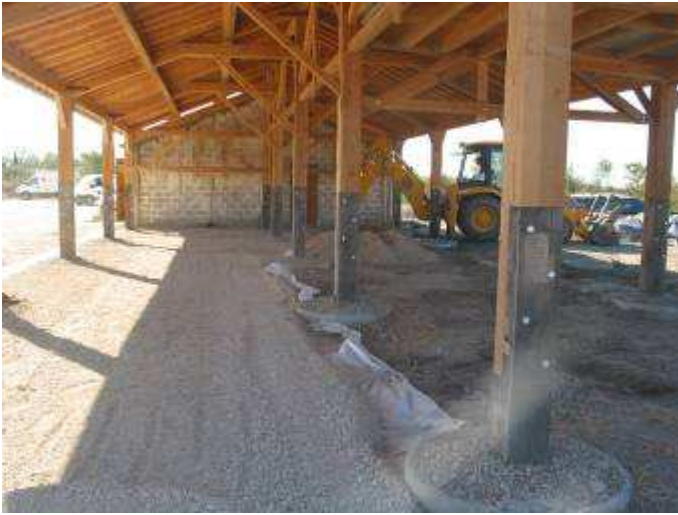
Stabilisation du sol du hangar à foin et aménagement des abords de la bergerie
