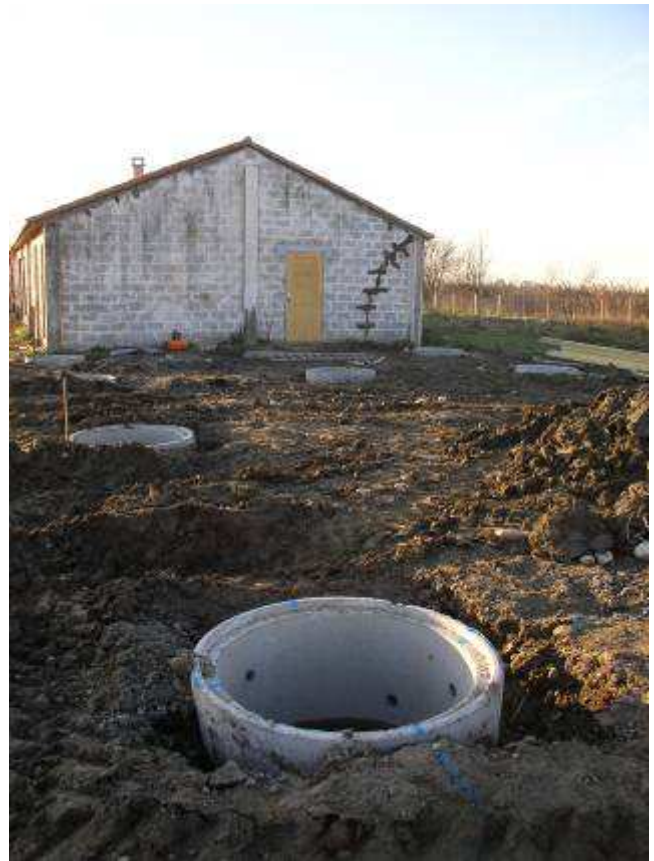
Mise en place des buses pour les fondations drainantes
