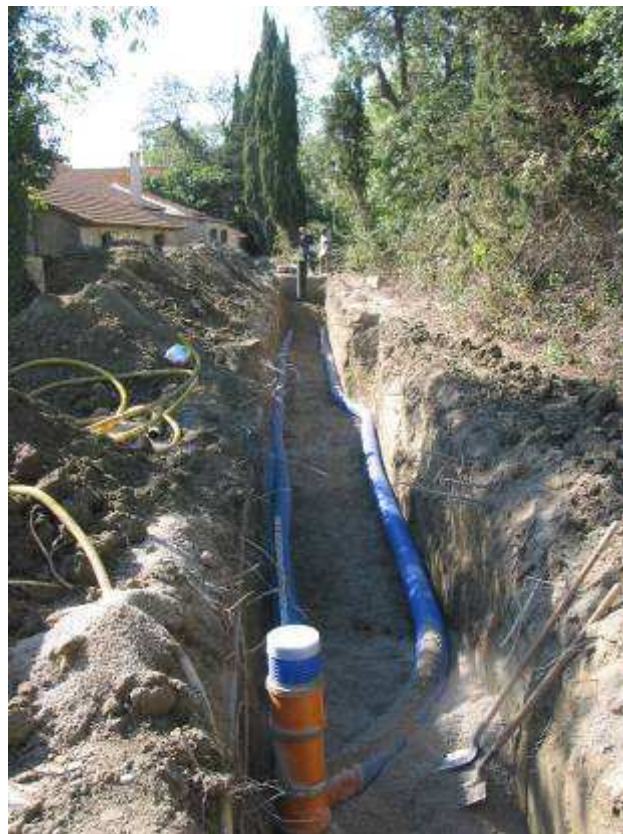
Pose du puits provençal, selon les indications du fournisseur
