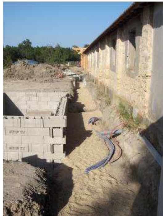
Pose du géotextile, présentation des regards, pose des gaines électriques, réseaux d'eau potable et pluviale, eaux usées
