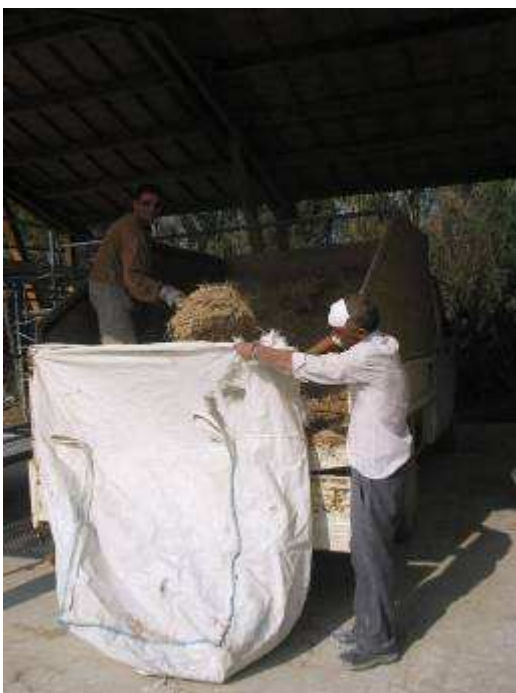
Déchargement des roseaux broyés et préparation du mélange
