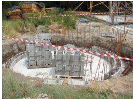
Fondations et montage des murs de la troisième cuve
