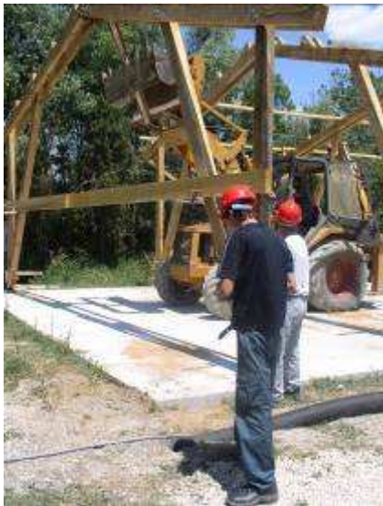
Assemblage au sol et mise en place progressive avec un tractopelle (structure en chêne lourd)
