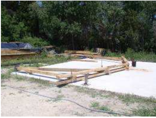
Assemblage au sol de la première ferme du hangar et mise en place
