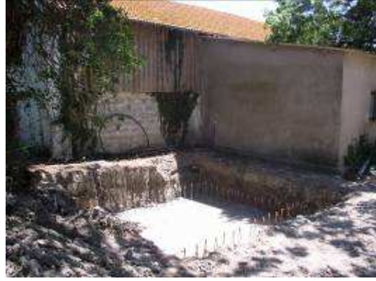
Préparation du treillis de fondations et réalisation des fondations
