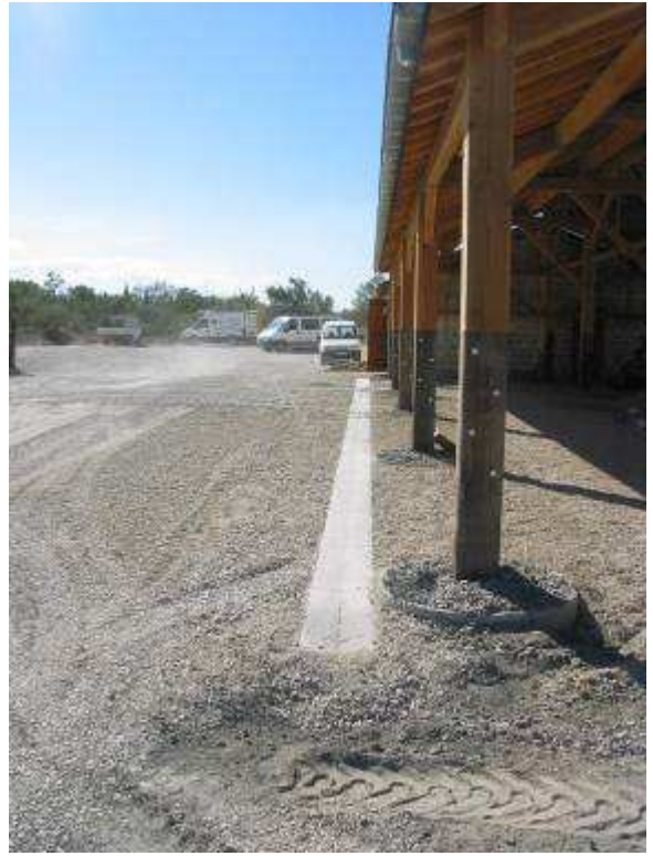
Stabilisation du sol du hangar à foin et aménagement des abords de la bergerie
