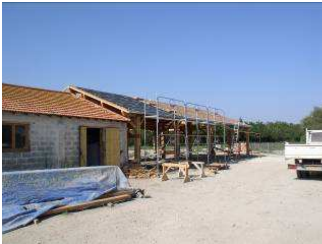
Pose des panneaux solaires photovoltaïques
