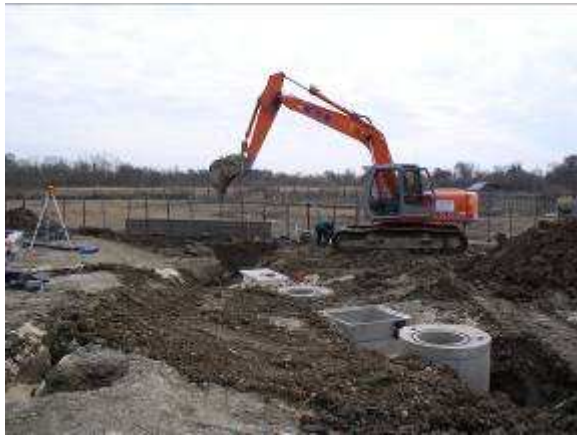
Pose des regards d'arrivée d'eau usée, du dégrilleur et du poste de relèvement
