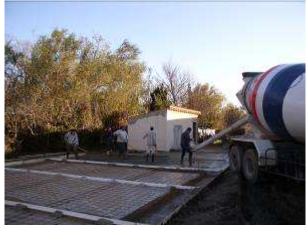
Réalisation de la dalle de la plateforme de stockage du bois (fondations, joints de dilatation, treillis)
