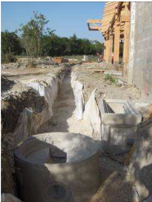
Pose du géotextile, présentation des regards, pose des gaines électriques, réseaux d'eau potable et pluviale, eaux usées
