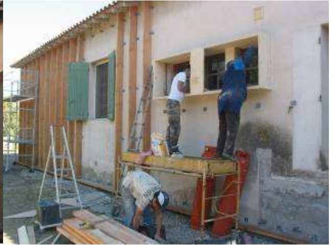
Mise en place de l'ossature en douglas, ainsi que des cadres qui recevront les fenêtres extérieures
