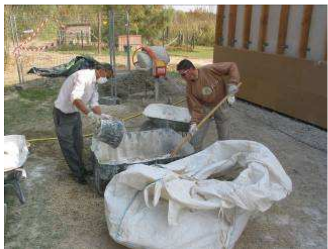
Déchargement des roseaux broyés et préparation du mélange
