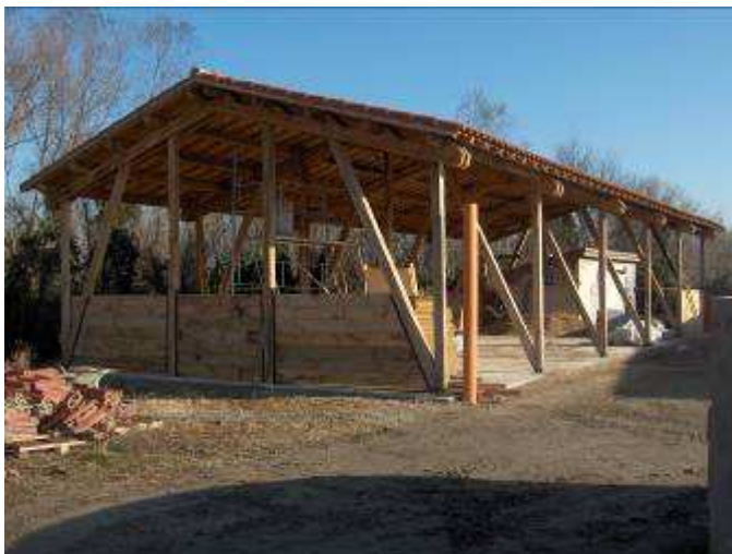
Murs amovibles en bois pour le stockage du bois décheté
