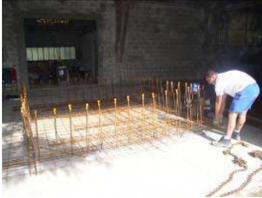
Préparation du treillis de fondations et réalisation des fondations
