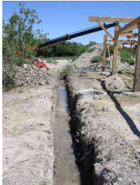
Photo avant travaux et tranchée initiale
