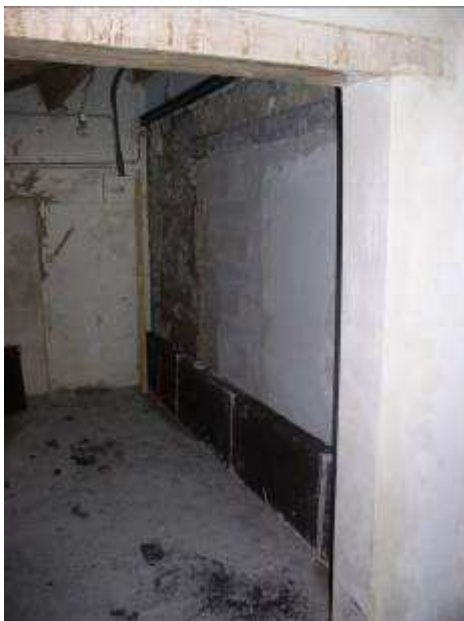
Réalisation de l'isolation par l'intérieur des espaces tampons, en liège de 10cm.
