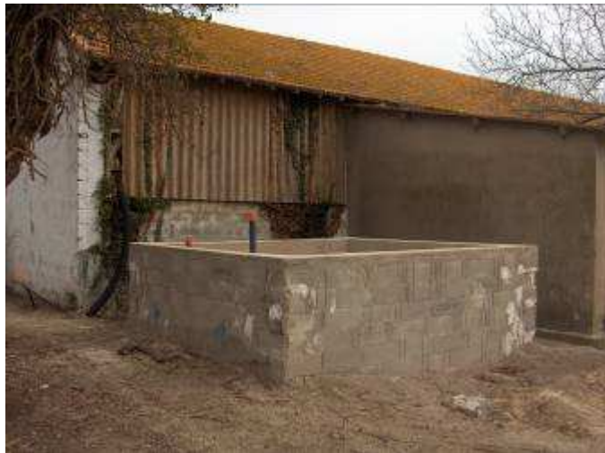
Fin du gros œuvre de deuxième cuve, en attente de finitions
