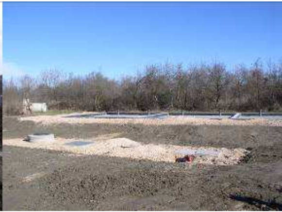
Pose des regards d'arrivée d'eau usée, du dégrilleur et du poste de relèvement
