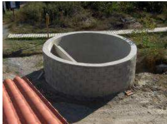
Réalisation des réservations (connexion des cuves entre elles, trop-plein) et du décanteur
