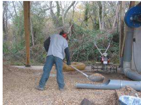
Détail du système d'alimentation du silo de la chaufferie (aspirateur à copeaux)
