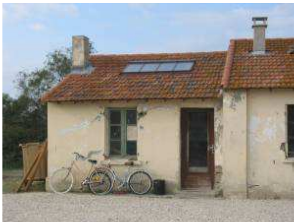
Bergerie (2m 2 de capteurs solaires thermiques)
