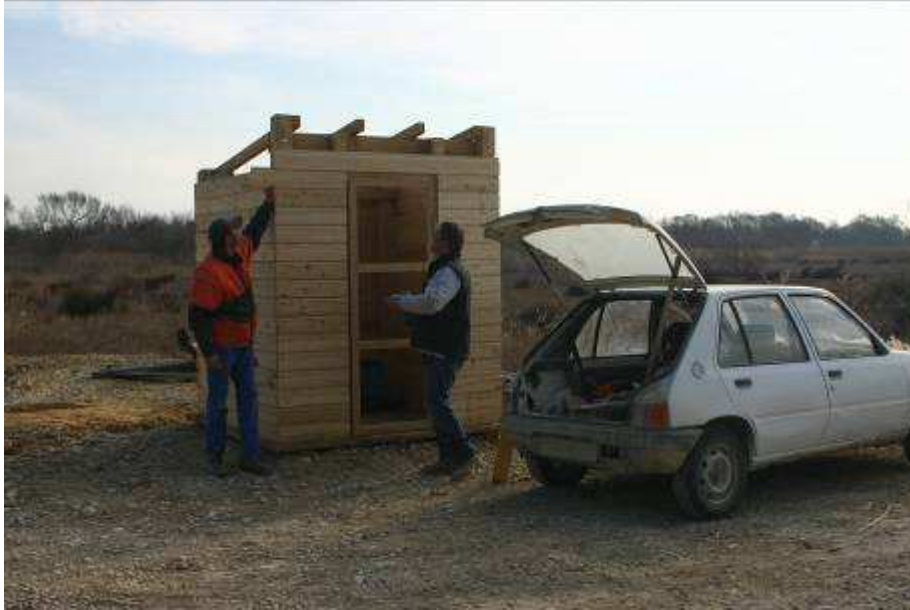
Réalisation de la cabane de pesée des déchets (chêne et mélèze)
