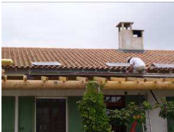
Reprise des auvents de la maison des gardes en vue de l'installation des systèmes solaires thermiques et photovoltaïques
