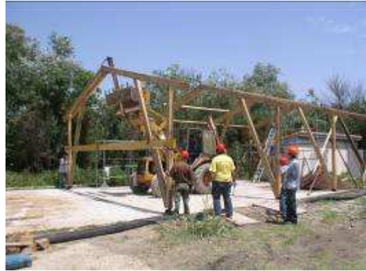
Assemblage au sol et mise en place progressive avec un tractopelle (structure en chêne lourd)
