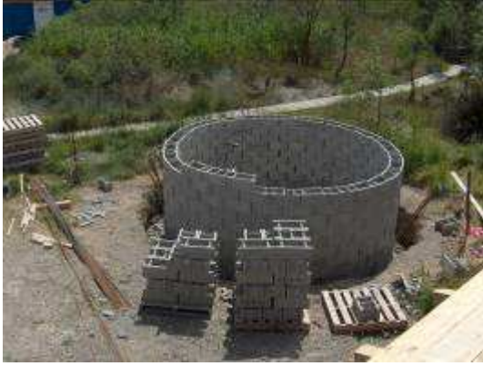
Fin du montage des murs
