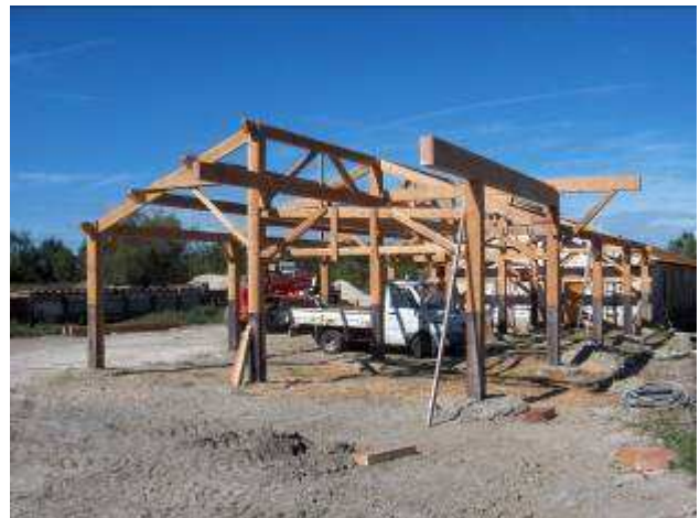
Montage de l'ossature en douglas du hangar
