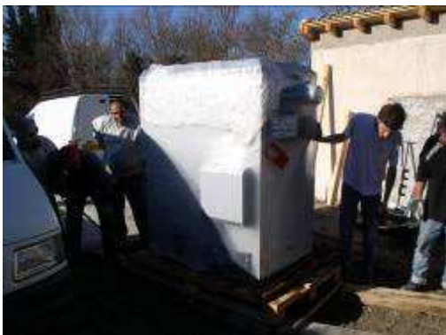
Déchargement de la chaudière bois (Hertz de 90kW) et pose des sabots de maintien de la structure bois
