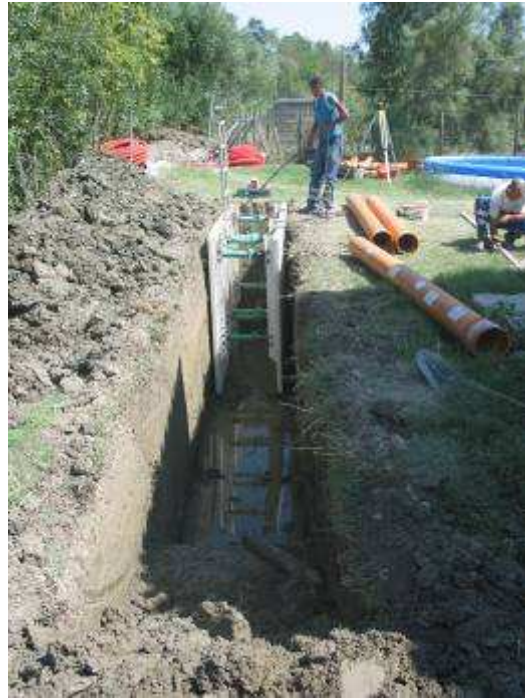
Pose du réseau d'eaux usées
