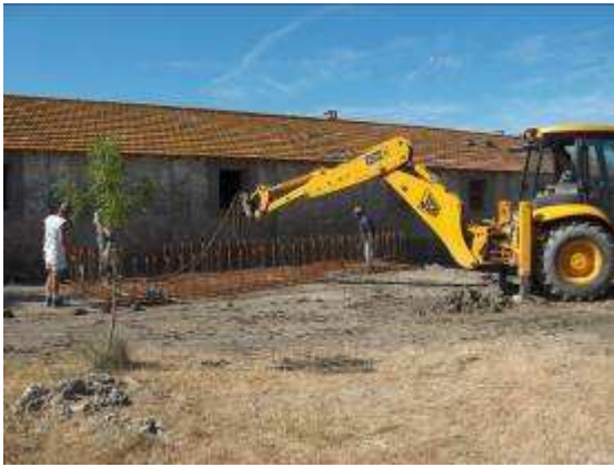
Pose du treillis et réalisation des fondations
