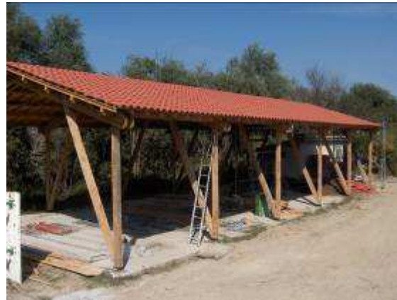
Pose des tuiles après traitement au sel de bore au pulvérisateur
