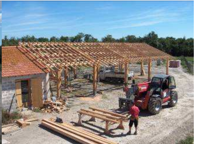
Montage de l'ossature en douglas du hangar
