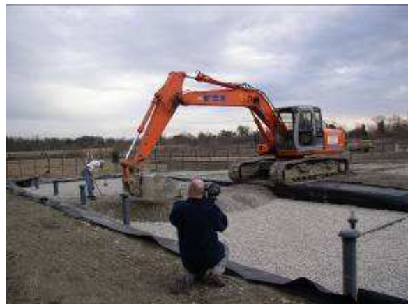
Pose des drains en fond de lit, des 4 couches de graviers, de la ventilation et des évacuations, des aménagements d'eau usée et des bordures du lit
