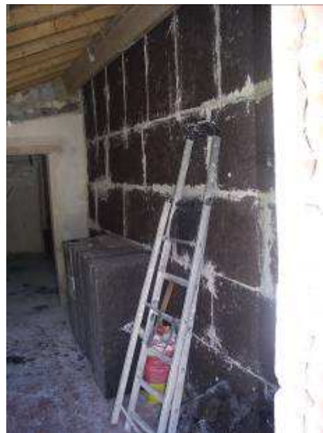
Réalisation de l'isolation par l'intérieur des espaces tampons, en liège de 10cm.
