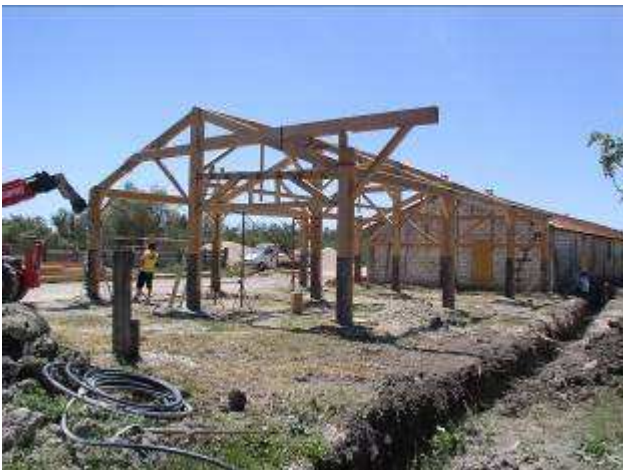
Montage de l'ossature en douglas du hangar
