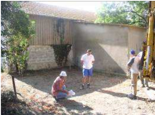
Positionnement de la deuxième cuve et creusement
