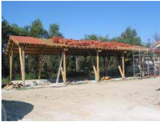
Pose des tuiles après traitement au sel de bore au pulvérisateur
