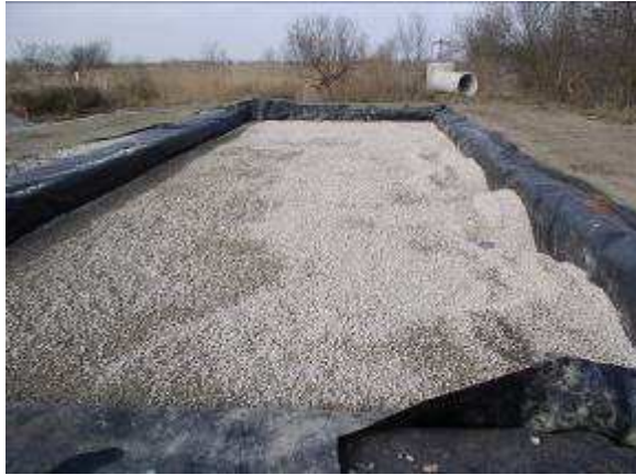
Pose des drains en fond de lit, des 4 couches de graviers, de la ventilation et des évacuations, des aménagements d'eau usée et des bordures du lit
