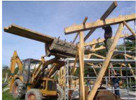
Assemblage au sol et mise en place progressive avec un tractopelle (structure en chêne lourd)
