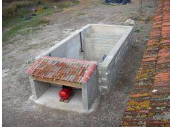
Décanteur fini (la partie haute permet d'éviter l'intrusion de feuille dans la cuve centrale) et aspect finalisé
