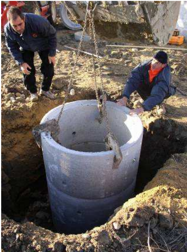
Mise en place des buses pour les fondations drainantes
