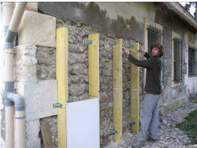
Tests préalables à l'utilisation de roseaux en isolation (roseaux seuls ou en mélange avec de la chaux ou de l'argile)
