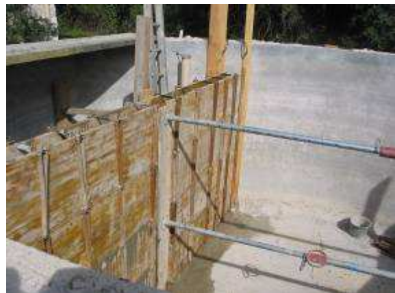
Réalisation de l'enduit d'étanchéification et du décanteur
