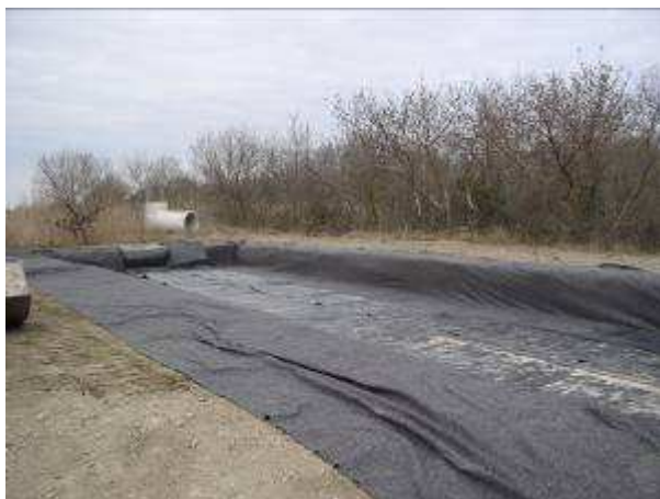
Pose du feutre de fond de lit et de la membrane d'étanchéité
