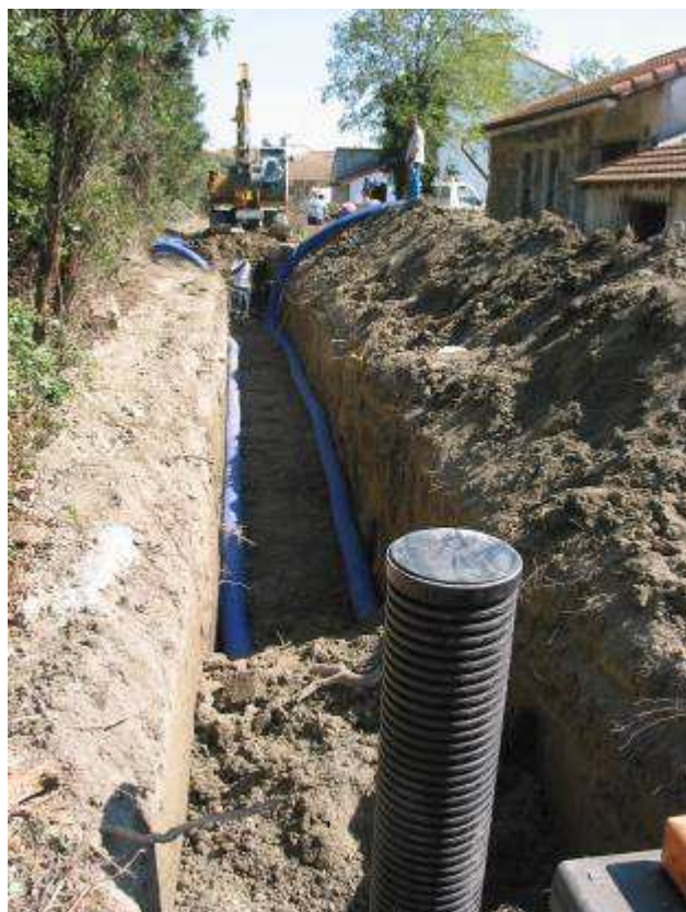
Pose du puits provençal, selon les indications du fournisseur
