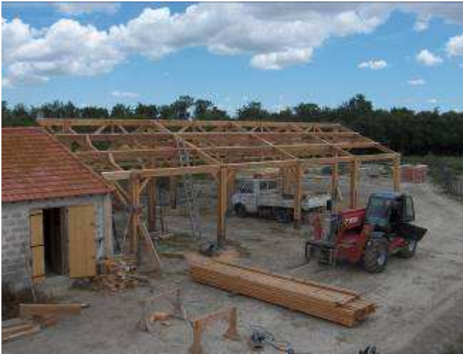
Montage de l'ossature en douglas du hangar
