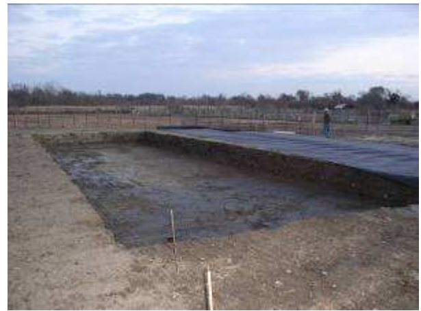
Réalisation du fond de forme et présentation du feutre de fond de lit
