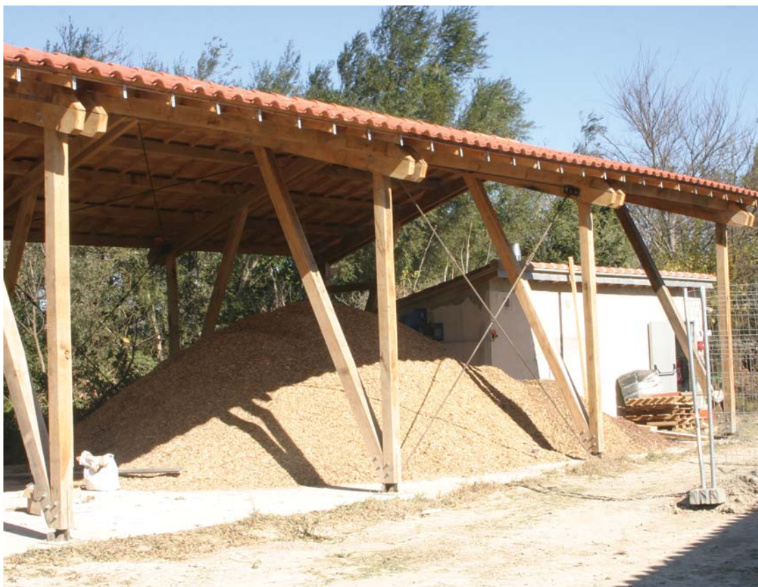
plateforme de séchage du bois et chaufferie
