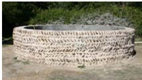
Cuve de récupération des eaux de pluie
