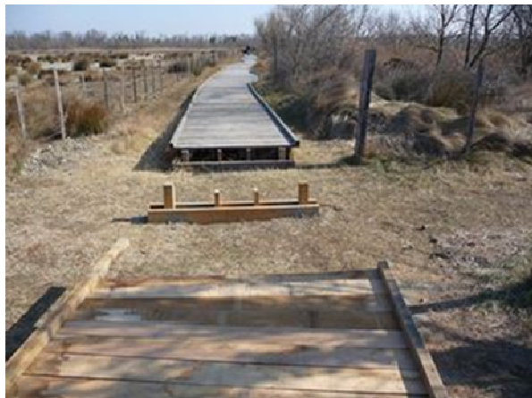
Figure 146 : Point de passage mobile pour laisser passer les engins vers les marais
