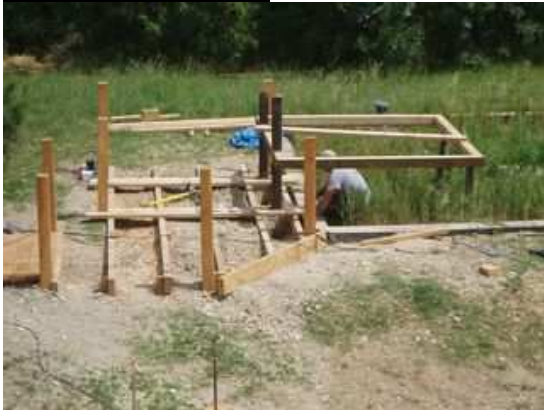
Figure 154 : Finition du platelage de la plate-forme traitement des eaux usées
