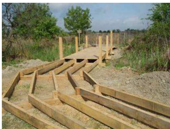
Figure 150 : Connexion du plancher de la passerelle au plancher du sentier
