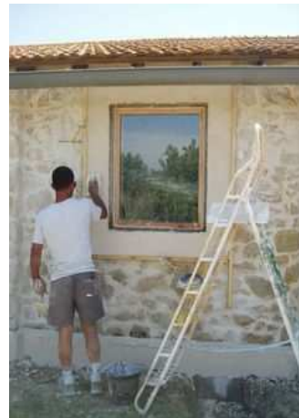
Figure 210 : reprise des tableaux des fenêtres
