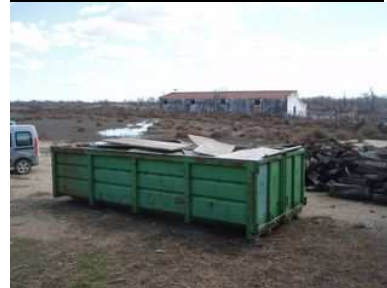
Figure 214 : évacuation des déchets de bois non traité par une benne mise à disposition par la ville d'Arles
