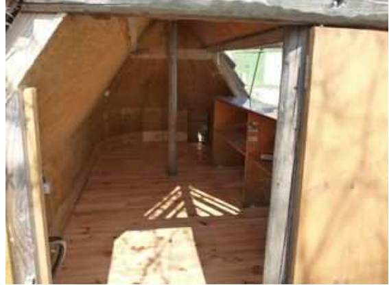
Figure 177 : Vue de la buvette les travaux finis
