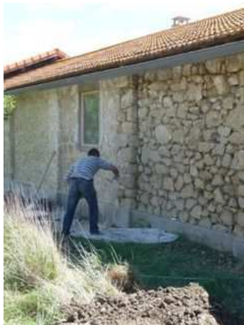
Figure 211 : pose des joints des pierres
