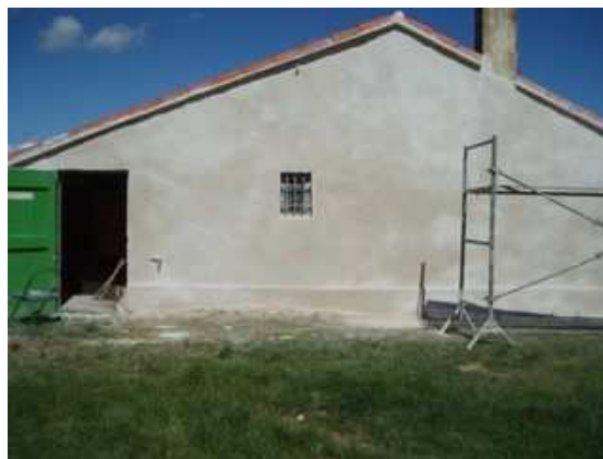
Figure 212 : vue de la façade ouest finie
