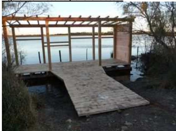
Figure 168 : Pose du plancher d'accès
