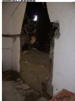
Figure 204 : Remplissage du mur par un mélange chaux, sable, roseau
