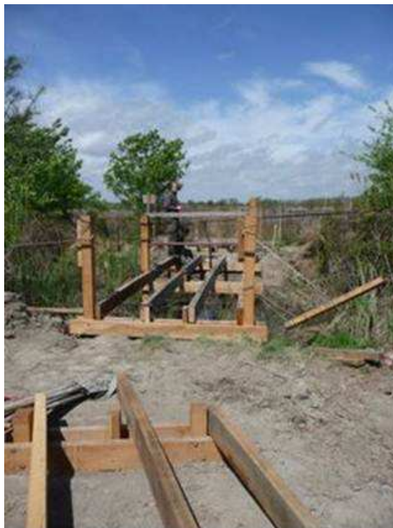
Figure 150 : Connexion du plancher de la passerelle au plancher du sentier
