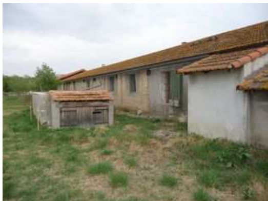
Figure 208 : vue générale de la bergerie avant travaux
