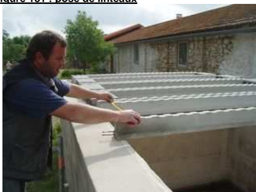
Figure 181 : pose de linteaux
