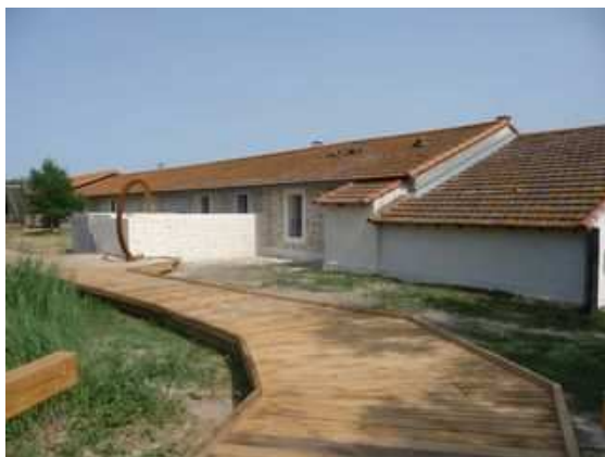
Figure 213 : vue des façades Nord de la bergerie finies
