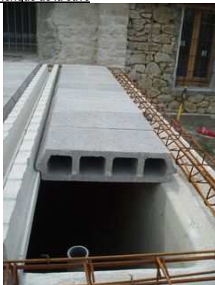
Figure 182 : pose d'entrevois et ferrailage de la partie périphérique de la cuve
