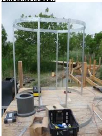
Figure 165 : Montage de la cabine des toilettes sèches : entreprise KAZUBA
