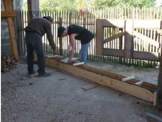
Figure 198 : réalisation d'un soubassement pour protéger le pied du mur terre roseau
