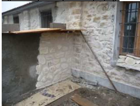
Figure 185 : pose de pierres de plaquage
