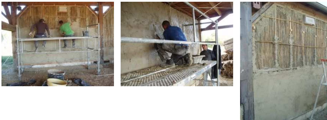
Figure 202 : vue du mur terre roseau une fois fini
