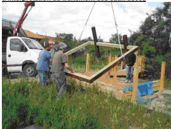
Figure 163 : Pose du cadre support des installations d'interprétation du traitement des eaux usées
