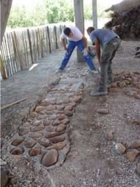
Figure 198 : réalisation d'un soubassement pour protéger le pied du mur terre roseau
