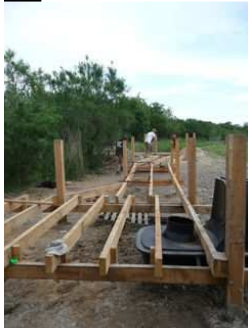
Figure 155 : Pose du platelage sur pilotis des toilettes sèches
