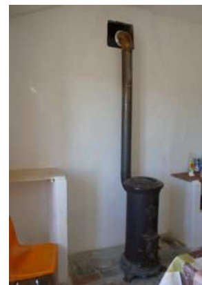
Figure 203 : Remplacement par un poêle à bois
