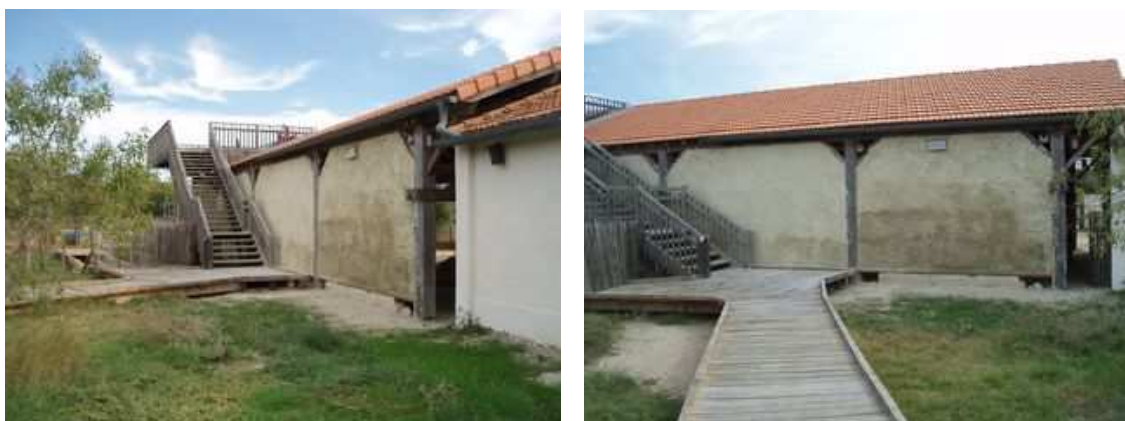
Figure 202 : vue du mur terre roseau une fois fini
