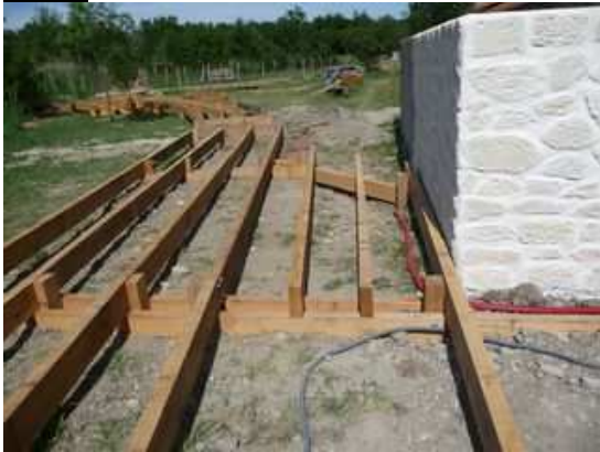
Figure 154 : Finition du platelage de la plate-forme traitement des eaux usées
