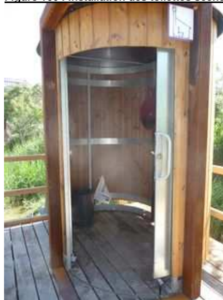
Figure 166 : Installation des toilettes sèches finie
