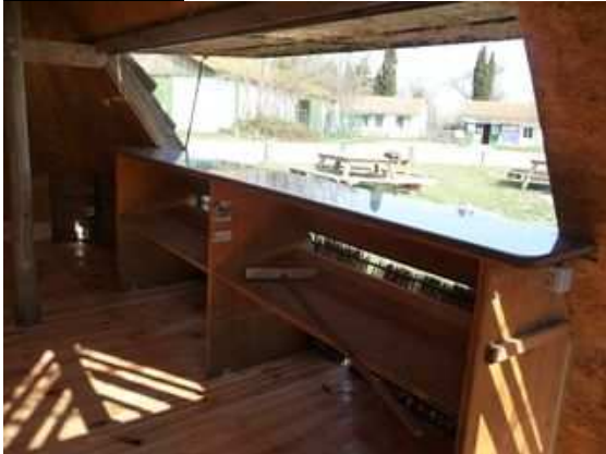
Figure 176 : Pose d'une plaque de zinc sur le comptoir et d'un plancher
