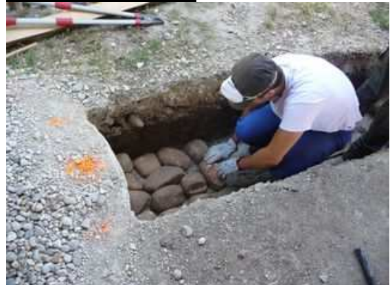
Figure 195 : pose d'un lit de galet de crau pour réaliser une fondation cyclopéenne
