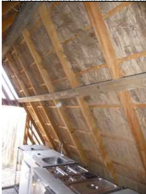
Figure 173 : vue initiale de l'intérieur de la buvette
