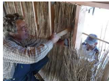
Figure 200 : réalisation de fagots de roseau, pose et « couture » des fagots sur l'ossature bois secondaire. Un grillage est agrafé pour maintenir l'ensemble
