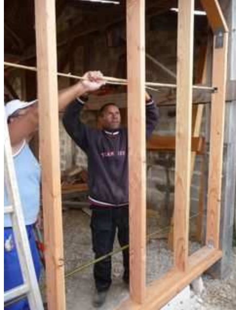
Figure 199 : pose d'une ossature bois secondaire pour tenir les nichoirs à oiseaux et servir de supports aux roseaux
