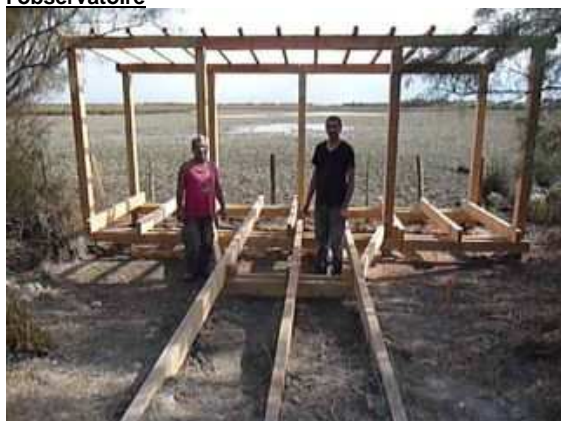
Figure 168 : Pose du plancher d'accès
