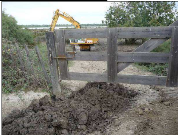
Figure 137 : Remise en état du passage à la sortie du Fangassier
