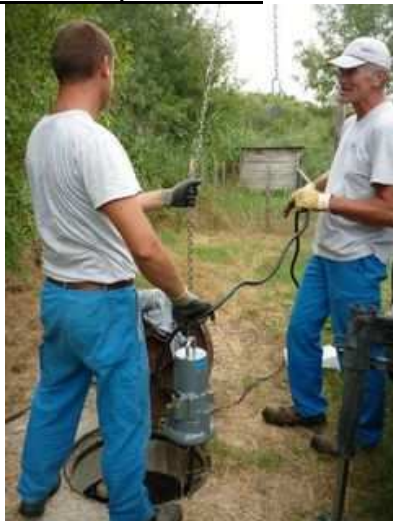
Figure 186 : changement de la pompe de refoulement et réparation du clapet anti retour
