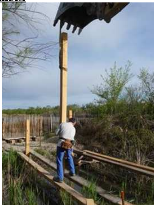
Figure 148 : Pose de poteaux en fondation d'une passerelle
