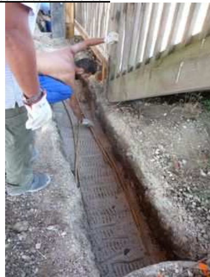
Figure 196 : pose de canne de Provence pour renforcer le béton de chaux
