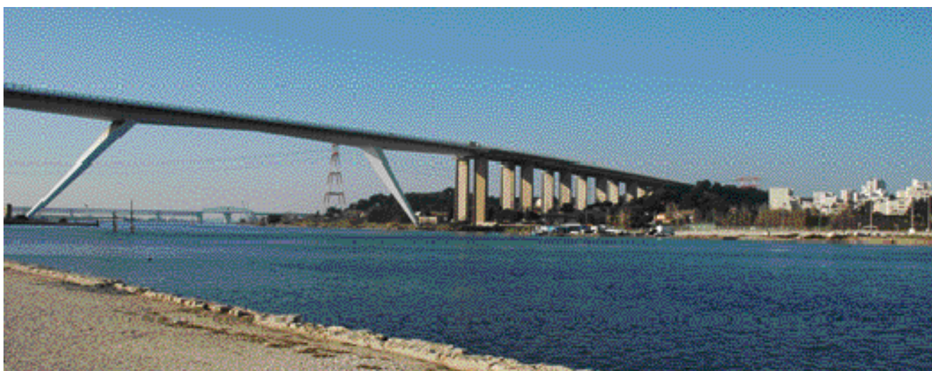
Le chenal de Caronte, le pont autoroutier et le quartier de la Croix-Sainte à Martigues
