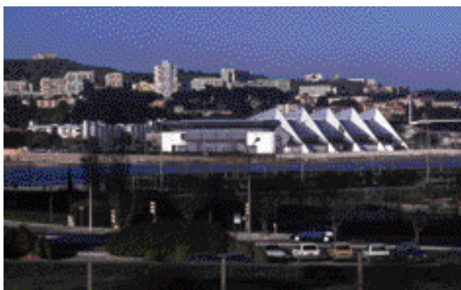
Extensions contemporaines à Martigues sur les rives du chenal de Caronte
