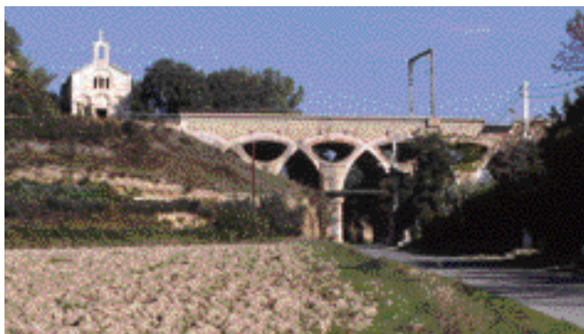
Le viaduc et la chapelle Saint-Léger à Saint-Chamas
