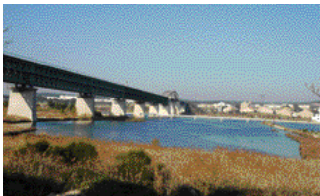
Le viaduc ferroviaire de Caronte date du XIXème siècle
