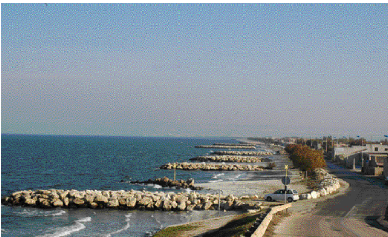
Le secteur Ouest du Jai, enrochements de protection et hameau de cabanons - décembre 2005
