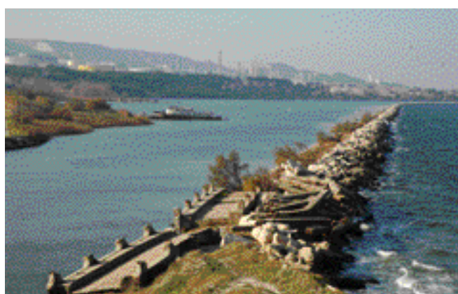
Le canal du Rove à la Mède et la digue littorale et en arrière-plan des raffineries sur le piémont
