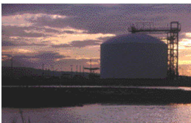
Réservoirs d'hydrocarbures aux salins de Berre
