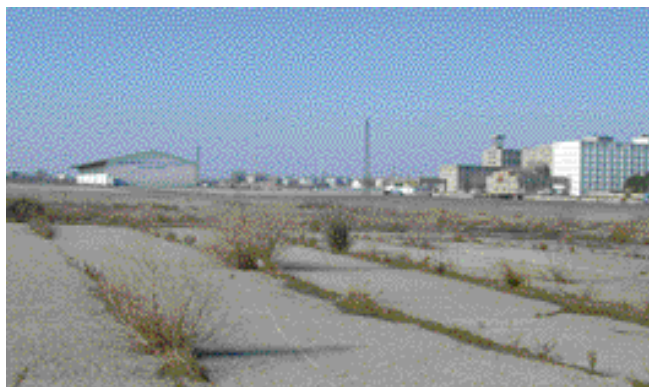
Le quai Saint Louis à Port-Saint-Louis-du-Rhône en friche en janvier 2005 : grue démontée, herbes folles...
