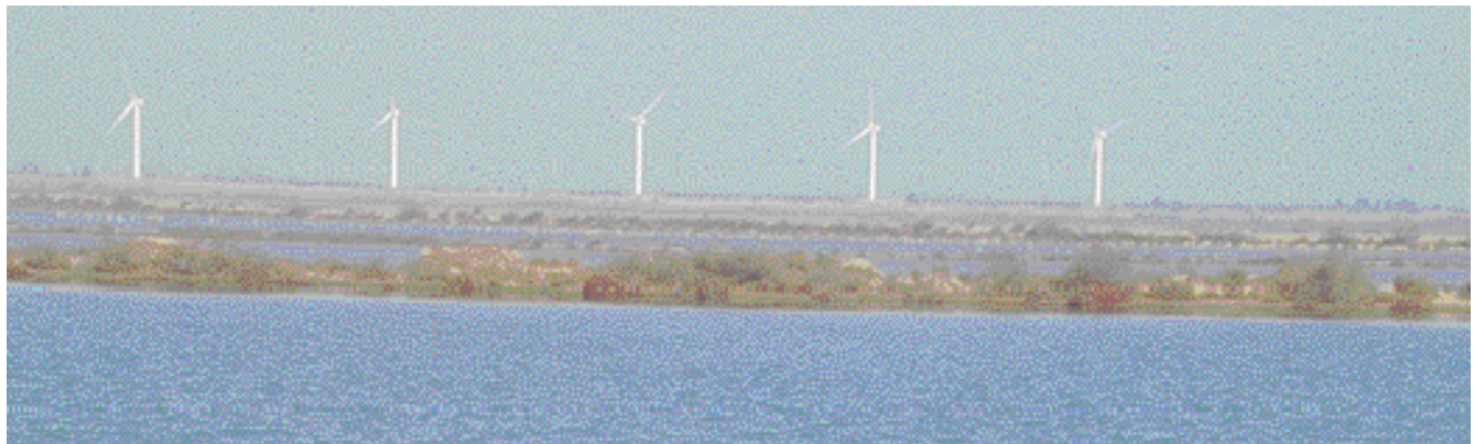
Fos-sur-Mer : les éoliennes en construction le long du canal du Rhône au Nord du salin de Caban, printemps 2005
