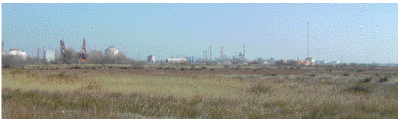
L'usine chimique et la darse n° 2 vues depuis la RN 268 sur les rives de l'étang de Caban
