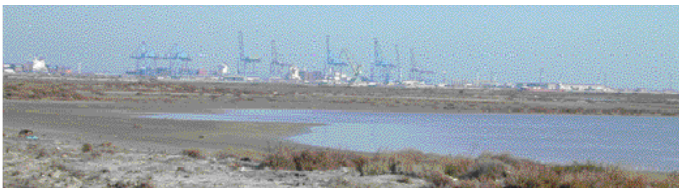
Depuis Malebarge, les grues du Terminal Conteneurs dominent le bassin du Gloria
