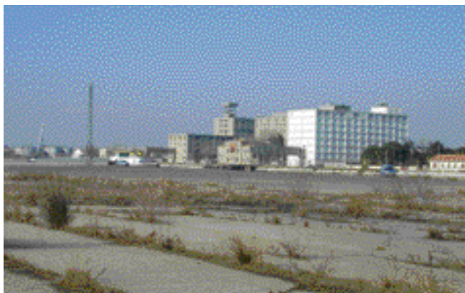
Port-Saint-Louis-du-Rhône : le quai du canal Saint-Louis
