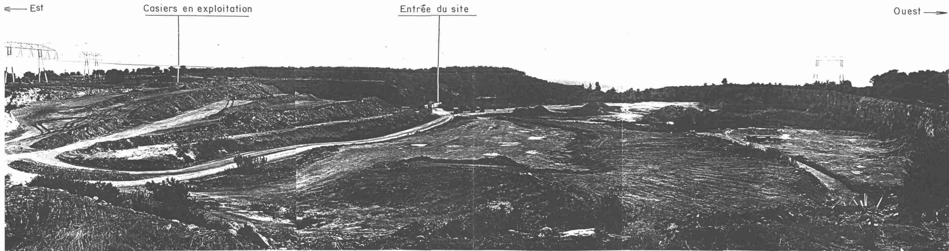
Vue panoramique depuis le Nord-Est
