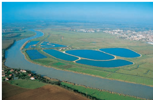
Vue aérienne de la station de lagunage © Ville de Rochefort
