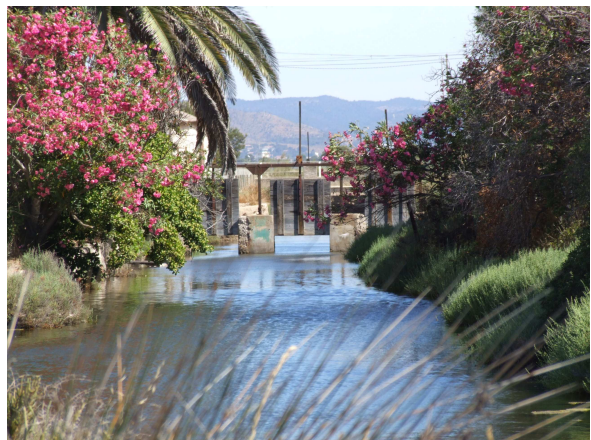
Martelières et canal de ceinture des salins de Pesquiers
