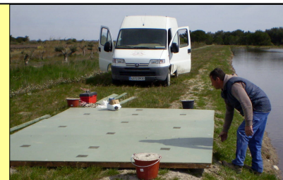
Fabrication et installation du radeau
