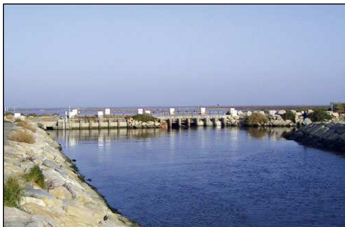
Figure 8 : Pertuis de la Fourcade et ses martellières de contrôle (Source MRM)
