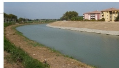
Illustration VI.37: Artificialisation des berges du Lez pour protéger les constructions en zone inondable (Lattes)
