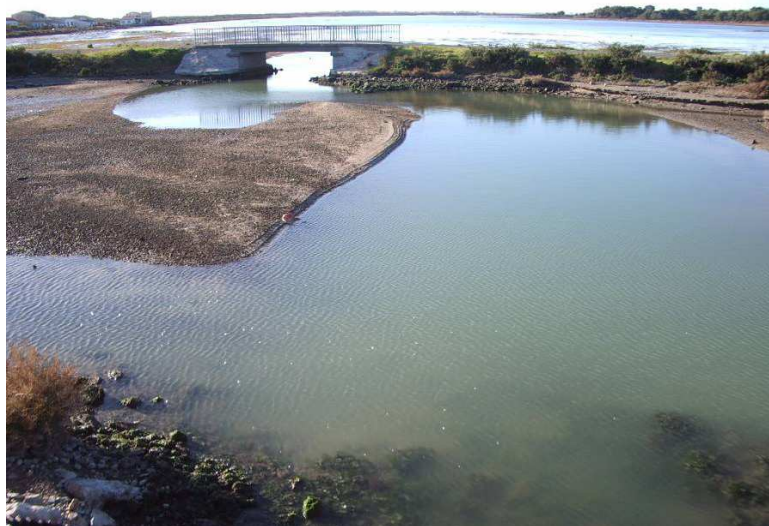
Encombrement de la passe entre les étangs de Vic et d'Ingril (vue du côté de l'étang d'Ingril) (source : SIEL, 2007 a)
