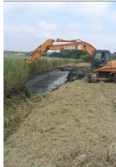
Travaux sur le canal de ceinture permettant la réalimentation en eau douce de l'étang de Vendres (source : SMBVA, 2008)
