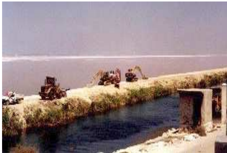
Travaux de comblement sur le lac Mariout (source : Abdelrehim, 2010)
