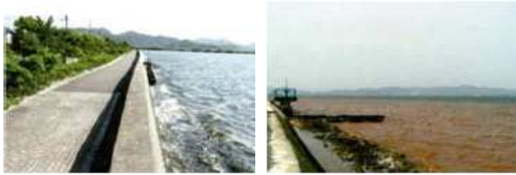
Exemples de dégradations du lac Nakaumi : à gauche, berge verticale et bétonnée, à droite, phénomène de « marée rouge » (source : the Nakaumi National Restoration Council, 2008)
