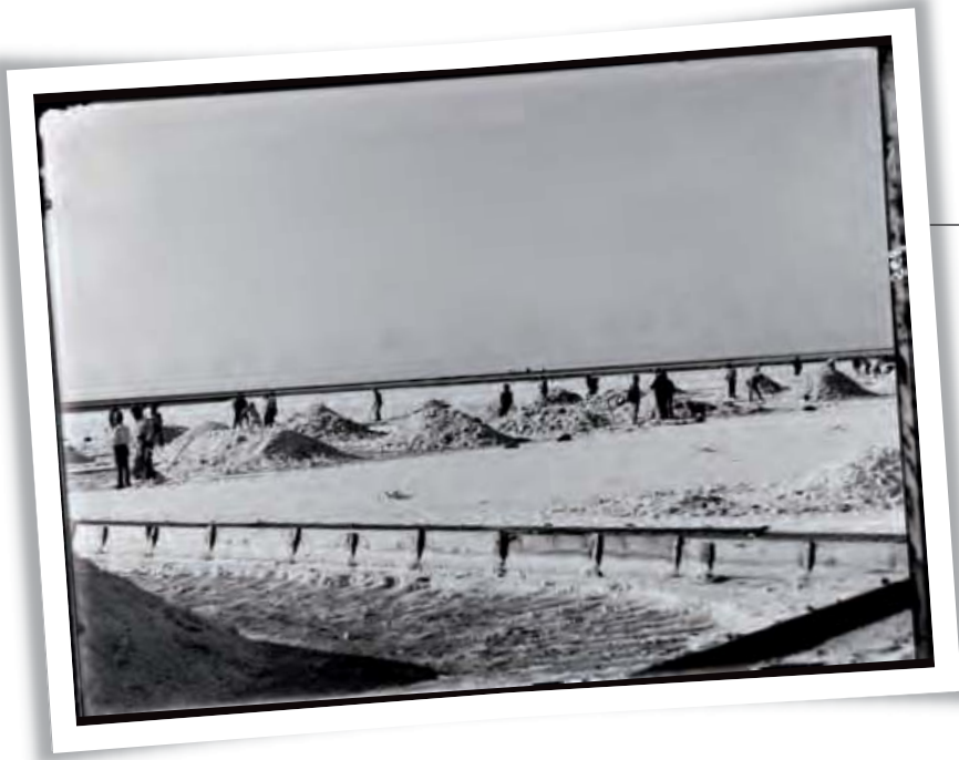
● Battage du sel par les ouvriers de la Société Péchiney à Salin-de-Giraud. Début du XX ème siècle.
