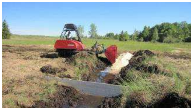
Photo 7 : colmatage à la sciure et compactage. (crédit CFD)
