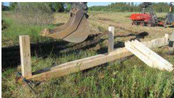
Photo 1 : installation des palissades en madriers (12 x 6 cm en épicéa) jusqu'au substrat minéral. (crédits CFD)
