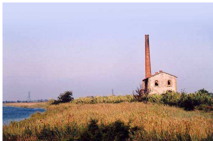
Figure 50 : La pompe à feu du Tonkin
