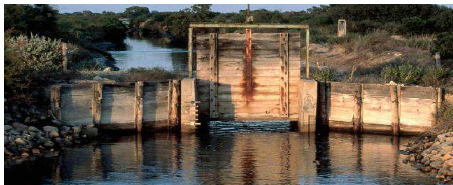
Image 21 : Martelière, ouvrage permettant la circulation d'eau entre les lagunes
