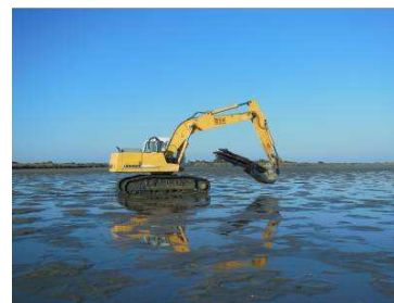
Une pelle mécanique a été utilisée pour façonner l'îlot
