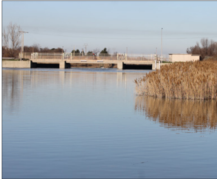
Photo 3 : ouvrage anti-sel, (Photo : port de Marseille Fos, 2014).
