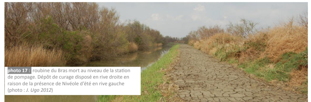
photo 17 : roubine du Bras mort au niveau de la station de pompage. Dépôt de curage disposé en rive droite en raison de la présence de Nivéole d'été en rive gauche (photo : J. Ugo 2012)
