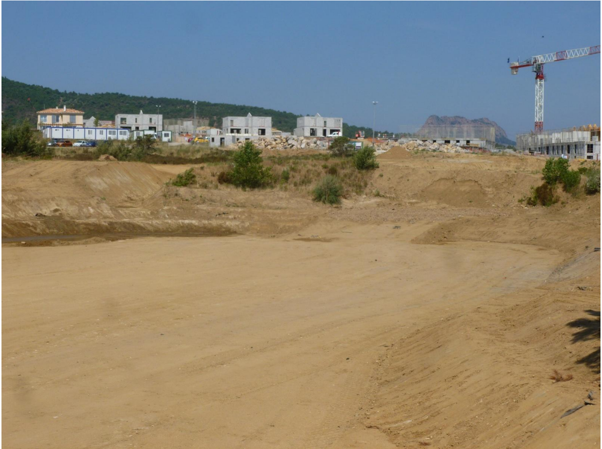
Figure 34 : Zone humide en cours d'aménagement, Roquebrune sur Argens, 2015
