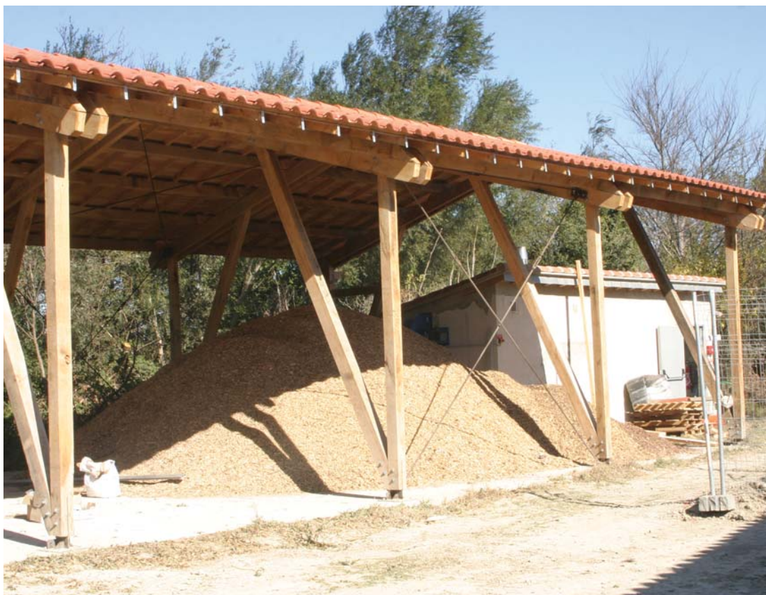
plateforme de séchage du bois et chaufferie
