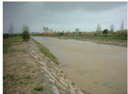
phénomène. Le **recalibrage et l'endiguement du lit des ruisseaux**, notamment celui du Réart, couplés à l'artificialisation des échanges avec la mer suite à la mise en place d'un **barrage à vannes à ouverture manuelle**, sans gestion adéquate, sont à l'origine de ces problèmes de comblement<sup>1</sup>. De plus, l'arrivée massive d'une grande quantité d'eau douce (parfois de mauvaise qualité) provoque une altération de la qualité d'eau de la lagune et une diminution de la diversité biologique.
