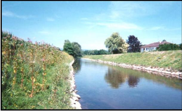
*Cours d'eau totalement artificialisé. Les berges sont complètement enrochées et la végétation a été supprimée. Ces travaux ne font que concentrer les problèmes hydrauliques en aval rendant les montées d'eau encore plus rapides et plus fortes. D'autre part, le milieu est fortement banalisé.*
