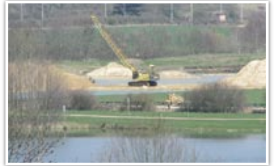
Carrière dans le lit majeur de l'Huisne
