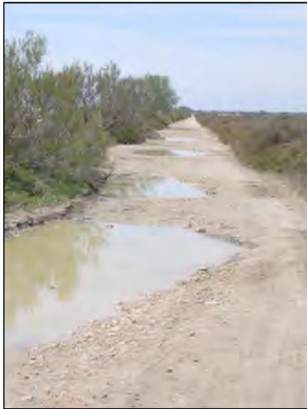
**Photo 0 : Phénomène d'érosion de chemin, lié au passage répété de véhicules motorisés et de VTT.**
