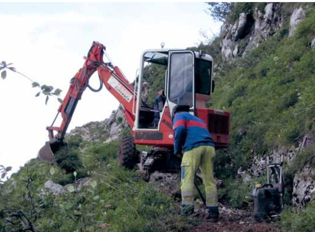
Restoration d'un sentier d'accès aux propriétés de l'ONCFS dans la Réserve des Bauges : élargissement et sécurisation préalable à la montée des génisses.
