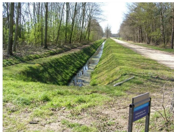
Watriingue. Ce terme désigne un réseau de fossés et d'ouvrages de drainage à vocation de dessèchement dans les polders du Nord de la France. Photo : Domaine public.
