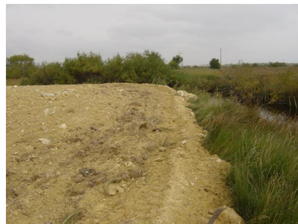
Remblai en zone humide. Crédit : Tour du Valat
