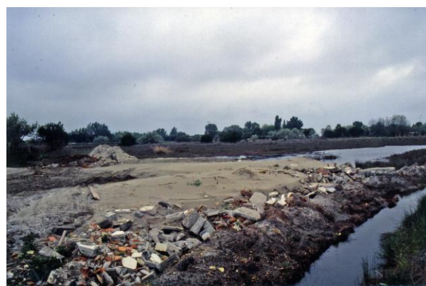
Remblai et abandon de déchets en zone humide. Crédit : Tour du Valat
