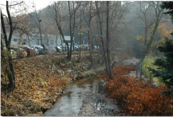
Remblai en bordure d'une zone inondable. Photo : Fabienne BARATIERYZERON
