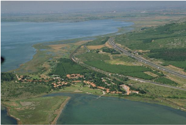
De haut en bas : Infrastructures routières et ferroviaire sur une lagune. Route et autoroute à proximité d'une lagune. Photos : FONBONNE.
