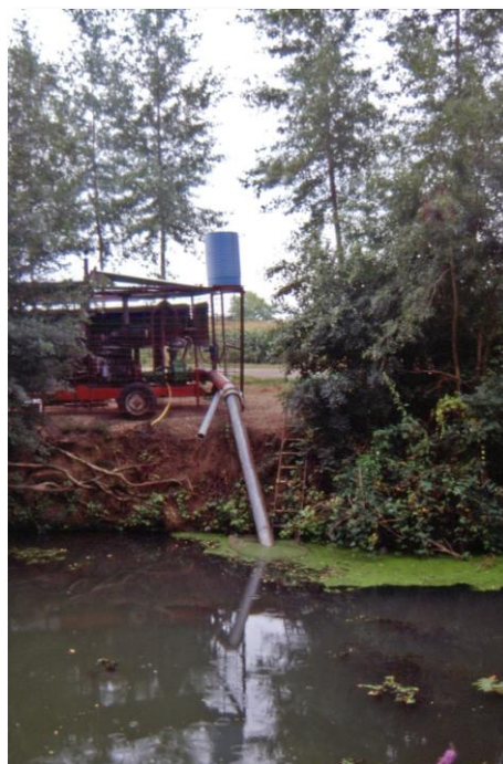
Captage d'eaux superficielles. Photo : Éric PARENT.
