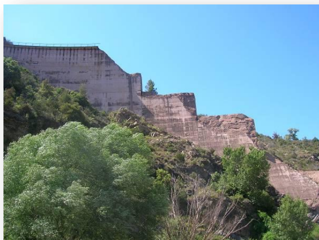
Ruines du barrage de Malpasset
