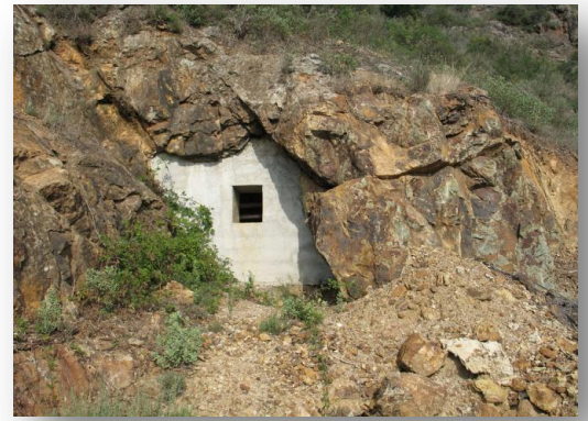
Une des entrées de la mine de l'Auriasque sécurisée avec une chiroptère
