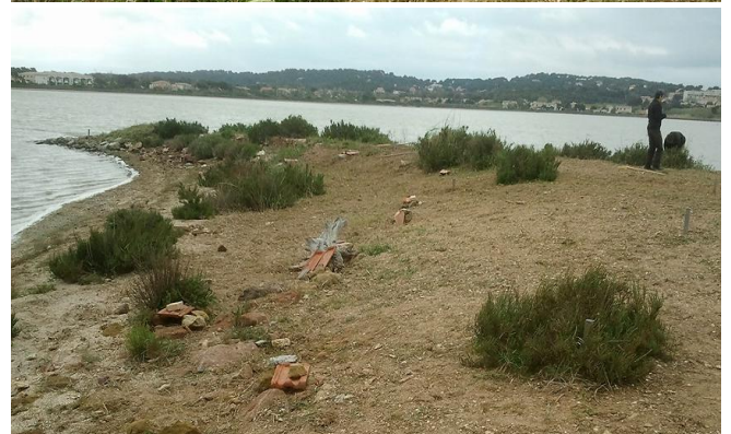
Chantier réalisé sur l'îlot à flamants : avant et après (A. Audevard)
