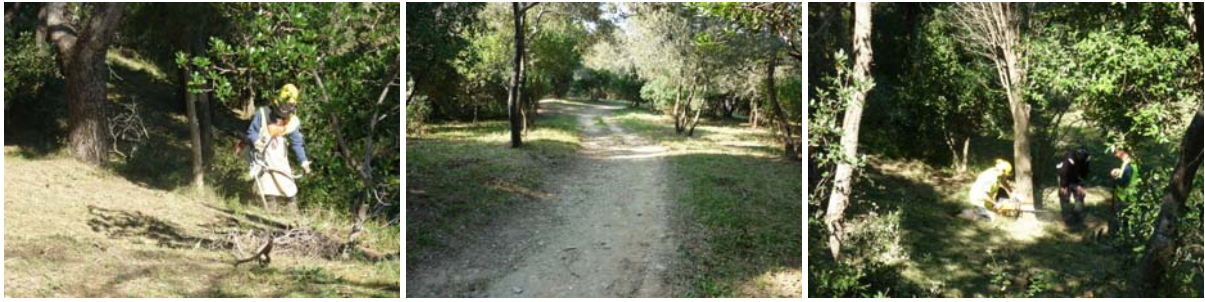
Débroussaillage sécuritaire des abords d'une piste et abattage, ASFV, février 2012
