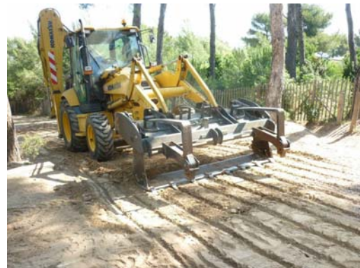
Rechargement en terre schisteuse et reprofilage du parking de la Darboussière
