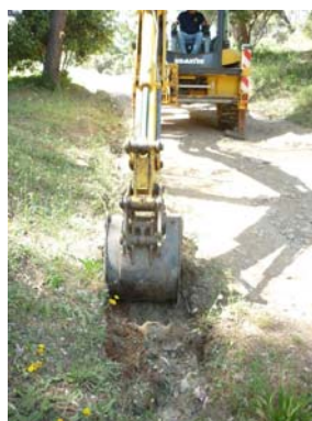
Entretien des buses et fossés d'évacuation des eaux
