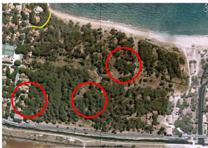
Zones de travaux
