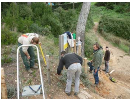
Chantier-école du 5 et 6 décembre 2012 (CFA d'Hyères) : Remplacement d'un dispositif de mise en défens à la Darboussière
