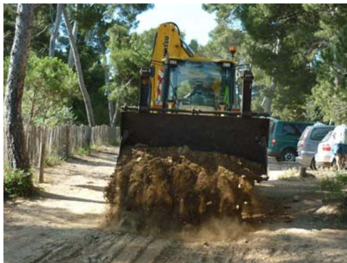
Rechargement en terre schisteuse et reprofilage du parking de la Darboussière
