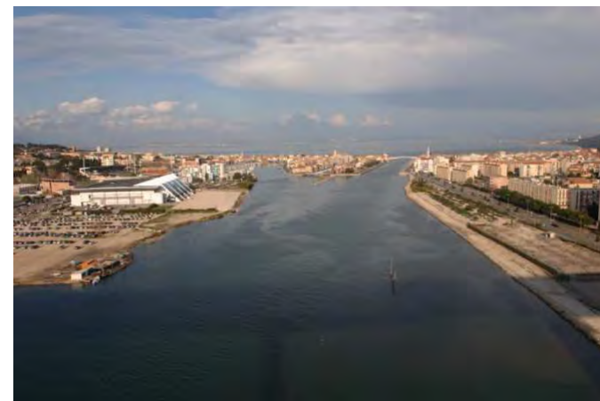
Rives urbaines du chenal de Caronte
