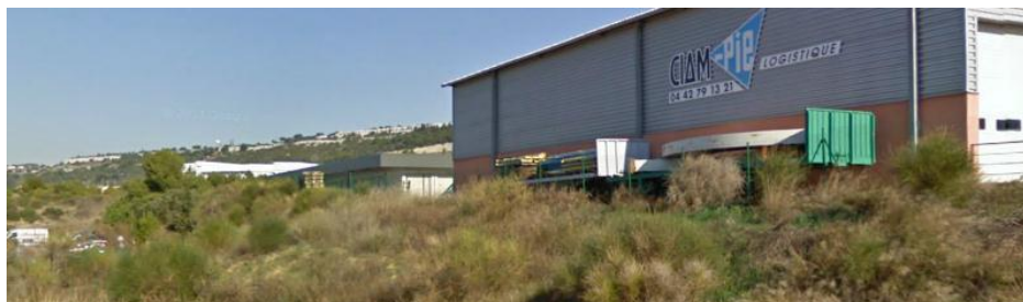
Végétation aux abords des bâtiments d'activités
