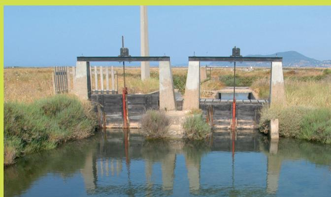
L'eau de mer est captée par un canal d'alimentation appelé le **Gras** (*grau = passage*). Les salins méditerranéens étant généralement situés sous le niveau de la mer, l'eau entre par les **portes martelières** et circule par gravité jusqu'aux étangs.
