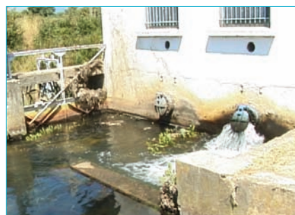
station de pompage sud
