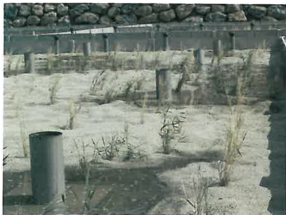
Filtres plantés de roseaux à Treilles
