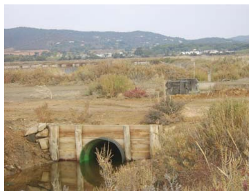
Pose d'un tuyau PEHD sous nouvelle piste d'accès (TPM – Régie et apport de matériaux BOUFFAL)
