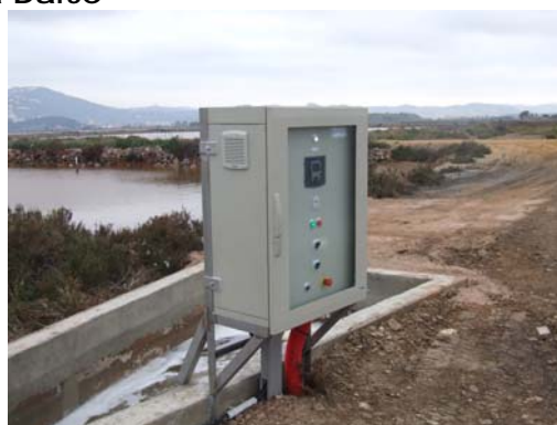
Changement de l'armoire de commande avec pose d'un variateur de vitesse (TPM – CES)
