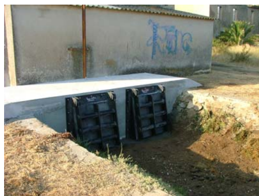
Fiabilisation de la station de pompage de la Remise : pose de clapets anti-retour (TPM – Capdevilla et Fils)
