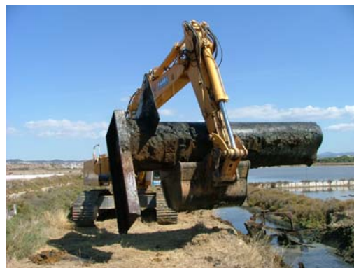
Suppression de l'assise de l'ancienne pompe Alta 300 (TPM - prestataire FABRE)
