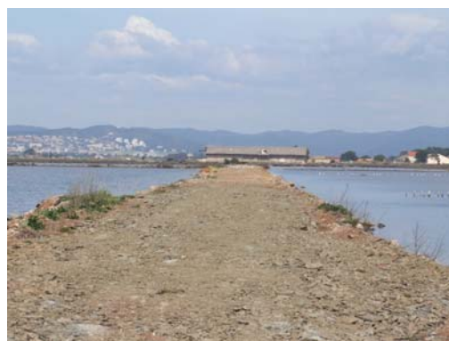
Traitement de surface sur les nouvelles digues des parténements de la Capte (TPM - Ets BROCCARDO)
