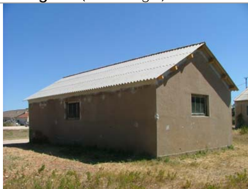
Remplacement de la charpente et toiture du local à carburant avec remplacement des plaques de fibro-ciment initialement amiantées (TPM - SACEB - 15 600 €TTC en 2006 et 4 767 €TTC en 2007)
