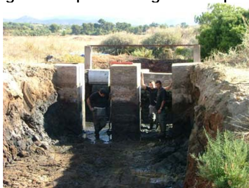
Déblaiement de la piste (TPM -FABRE – régie)
