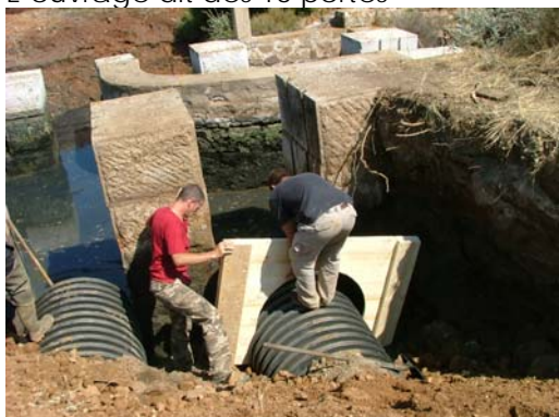
Remblaiement de la piste et habillage bois de soutien (TPM -FABRE – régie)
