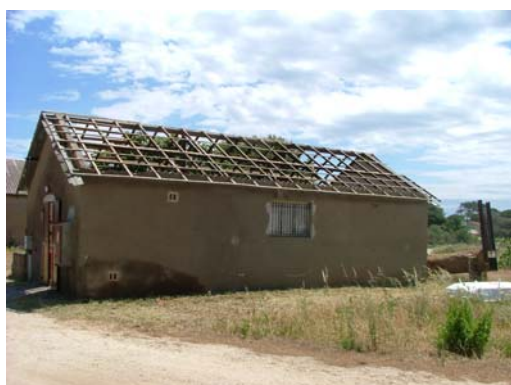
Remplacement de la charpente et toiture du local à carburant avec remplacement des plaques de fibro-ciment initialement amiantées (TPM - SACEB - 15 600 €TTC en 2006 et 4 767 €TTC en 2007)
