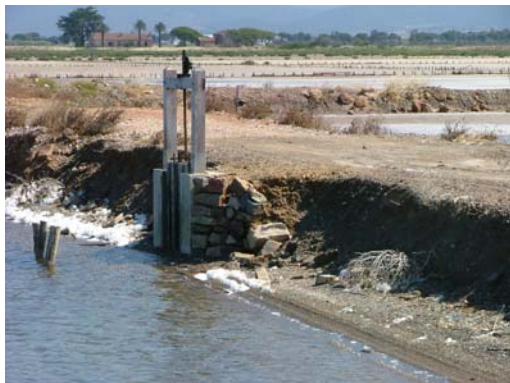
Renforcement des digues Sud et Est du Nouvel Etang au niveau de l'ouvrage de surverse du Nouvel Etang : avant/après (TPM – apport de matériaux M. ANDRES)
