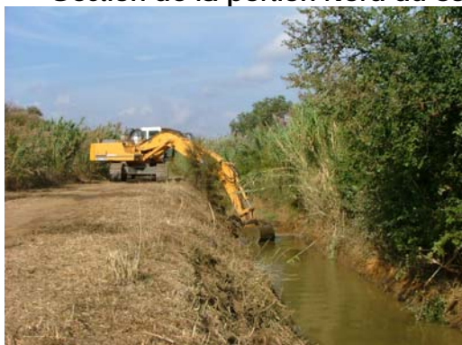
Curage après débroussaillage préalable (TPM – GRANET – FABRE°)
