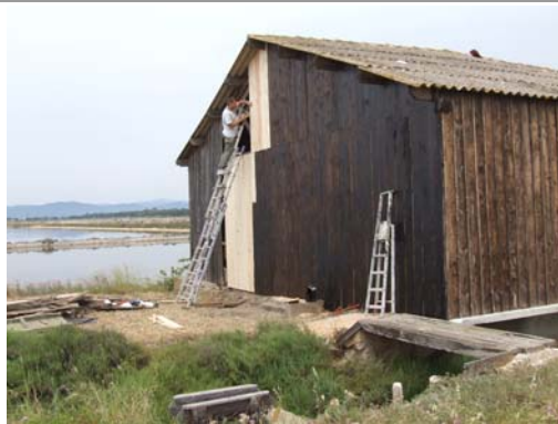
Restauration de la façade Ouest de l'ancienne menuiserie (TPM – Régie)
