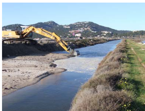
Désensablage du canal de ceinture du salin des Pesquiers – février 2007 (entreprise SPADA sous maîtrise d'ouvrage Commune d'Hyères)
