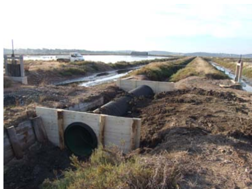
Renforcement des digues Sud et Est du Nouvel Etang au niveau de l'ouvrage de surverse du Nouvel Etang : avant/après (TPM – apport de matériaux M. ANDRES)
