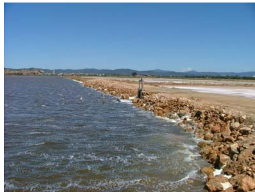
Renforcement des digues Sud et Est du Nouvel Etang au niveau de l'ouvrage de surverse du Nouvel Etang : avant/après (TPM – apport de matériaux M. ANDRES)
