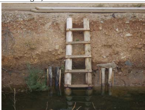
Echelle d'accès au barrage de « la Mère » (TPM – Régie)
