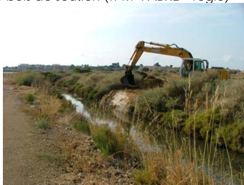
Suppression d'un ancien ouvrage métallique pour la restauration de la continuité du couloir d'alimentation du jeu de l'Olivâtre (TPM -FABRE)
