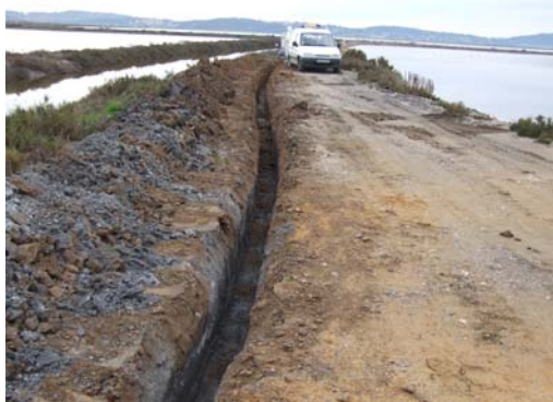
Nouvelle alimentation électrique enterrée (TPM – prestataire : CES)
