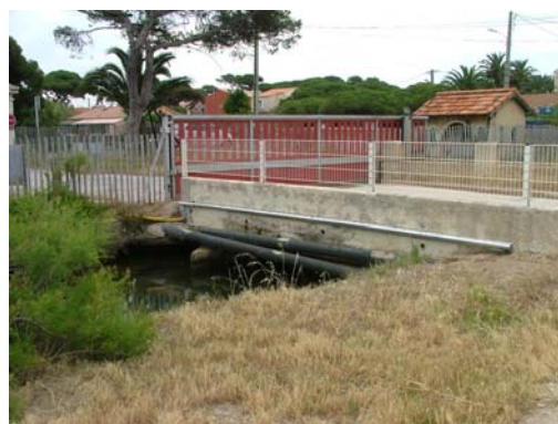
Changement de la canalisation d'eau potable en entrée de site (TPM - ARVIEU MOLINES)
