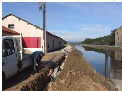
Réparation de la canalisation d'eau potable des ateliers à plusieurs reprises (TPM - Régie)
