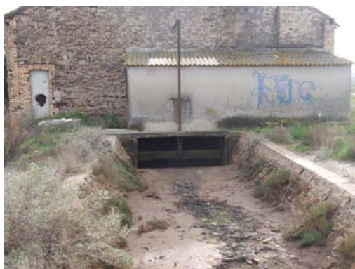
Fiabilisation de la station de pompage de la Remise : pose de clapets anti-retour (TPM – Capdevilla et Fils)
