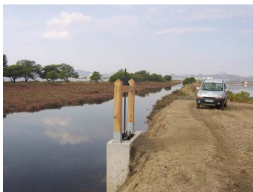
Pose d'un nouvel ouvrage hydraulique entre le canal d'alimentation et le jeu des Ournèdes (TPM – FABRE)
