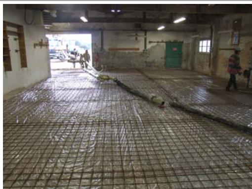
Réhabilitation de la dalle des ateliers (TPM – SACEB – 34 659 € TTC – 2006)
