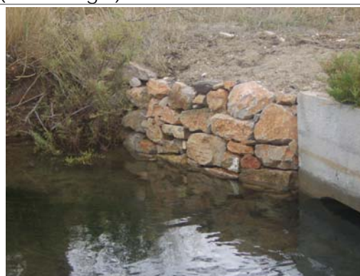
Empierrement pour le maintien des berges (TPM – Régie)
