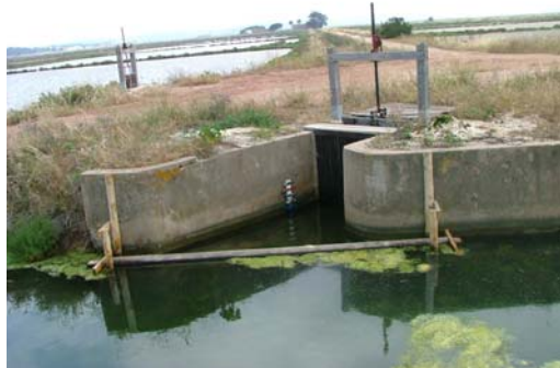
Barrage flottant contre les algues à la prise d'eau des partènements extérieurs du Salin des Pesquiers (TPM – Régie)
