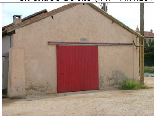
Remplacement de la porte coulissante extérieure du magasin de l'atelier (TPM - DEGIOANNI - 3 445 € TTC budget 2006)
