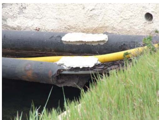
Etat de l'alimentation électrique du site le long du pont d'accès
