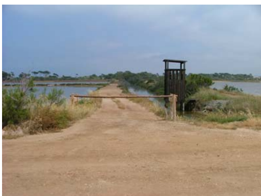
Pose d'une barrière sur la digue Sud des parténements de la Capte (TPM - Régie)
