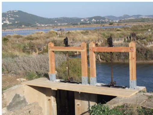
Réhabilitation de l'ouvrage d'alimentation de la Darse (TPM - régie technique)
