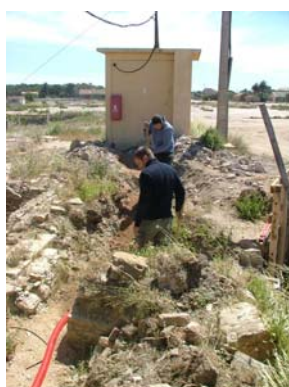
Enfouissement de la ligne électrique de l'ancienne menuiserie (TPM - Régie)
